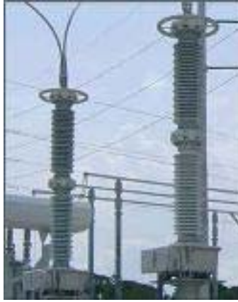
Fig. 3-28 : Alstom OTCF current transformer
