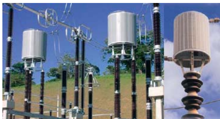
Fig. 3-40 : Alstom Grid line traps
