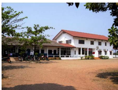
Bâtiments, à droite, bâtiment ancien à gauche, bâtiment rénové
