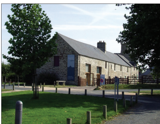
Fig. 6 : Maison de la Baie de Vains (2008)
