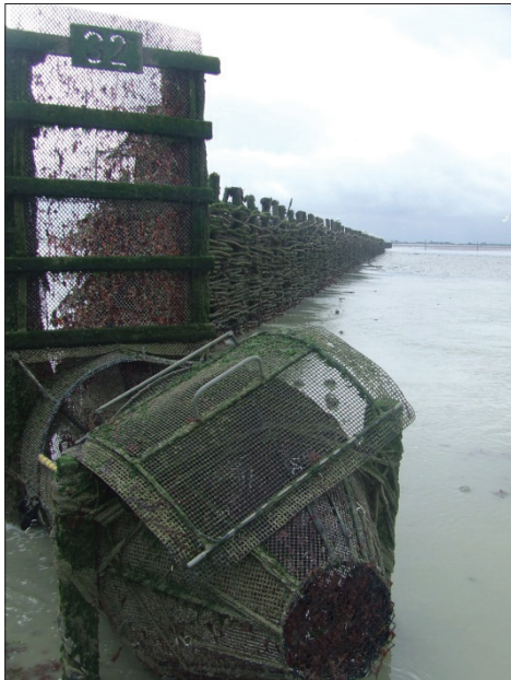
Fig. 5 : Bâchon de pêcherie, trappe ouverte. La partie haute de la pointe de la pêcherie est grillagée (2009).
