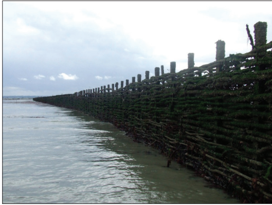
Fig. 4 : Panné en bois vue (vers la terre) de l'extérieur de la pêcherie (2009)
