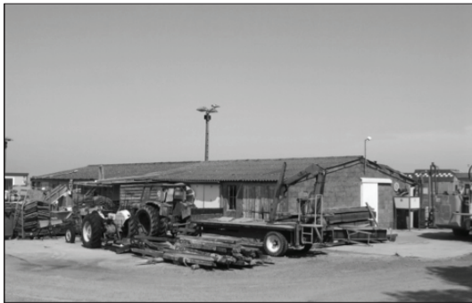
Fig. 12 : Les premiers bâtiments mytilicoles bâtis au Vivier-sur-Mer (2008)
