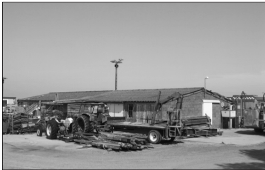
Fig. 12 : Les premiers bâtiments mytilicoles bâtis au Vivier-sur-Mer (2008)
