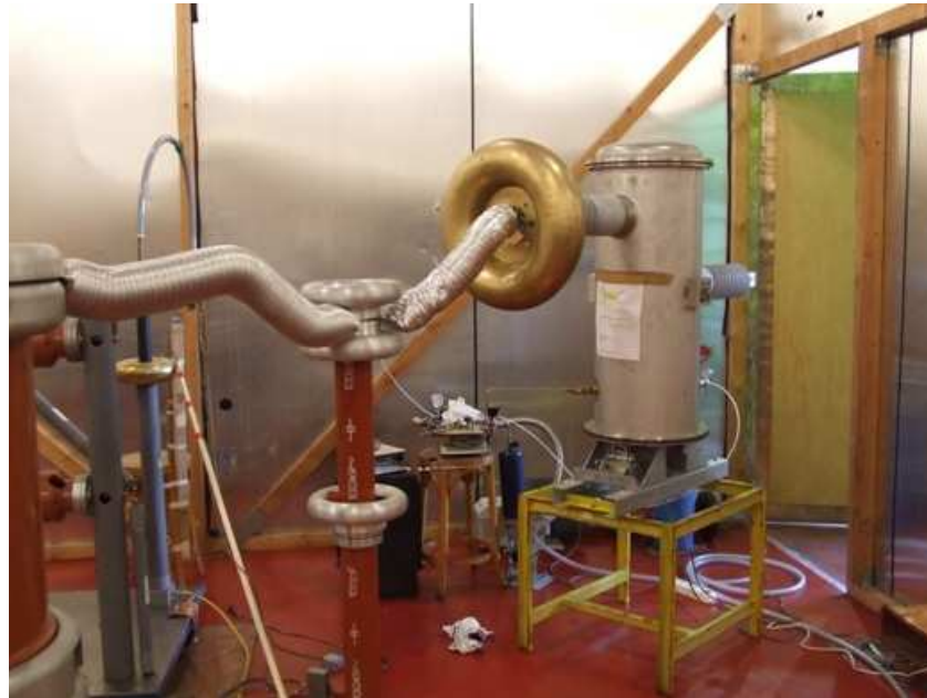
Fig. V-6 Vue d'ensemble du banc d'essai
