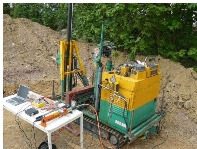
Figure V-4. Vue d'ensemble de la mise en place du matériel dans la zone retenue
