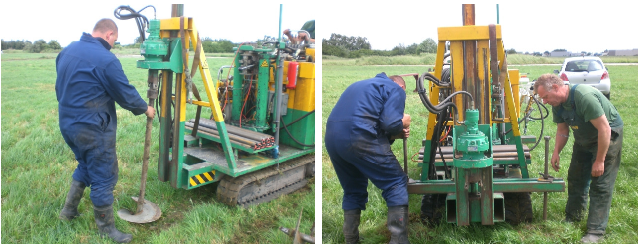
Figure III-3. Installation de la structure de réaction
