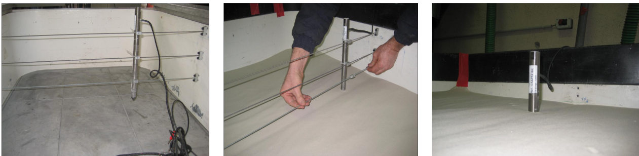
Figure VI-13. Mise en place du pieu instrumenté lors de l'avancement de la pluviation
