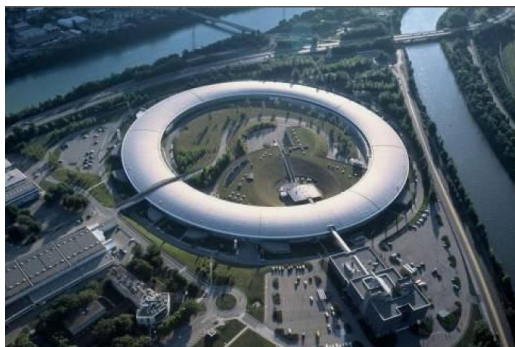
Figure 3-14: Photographie aérienne de l'ESRF de Grenoble (source : site internet de l'ESRF).
