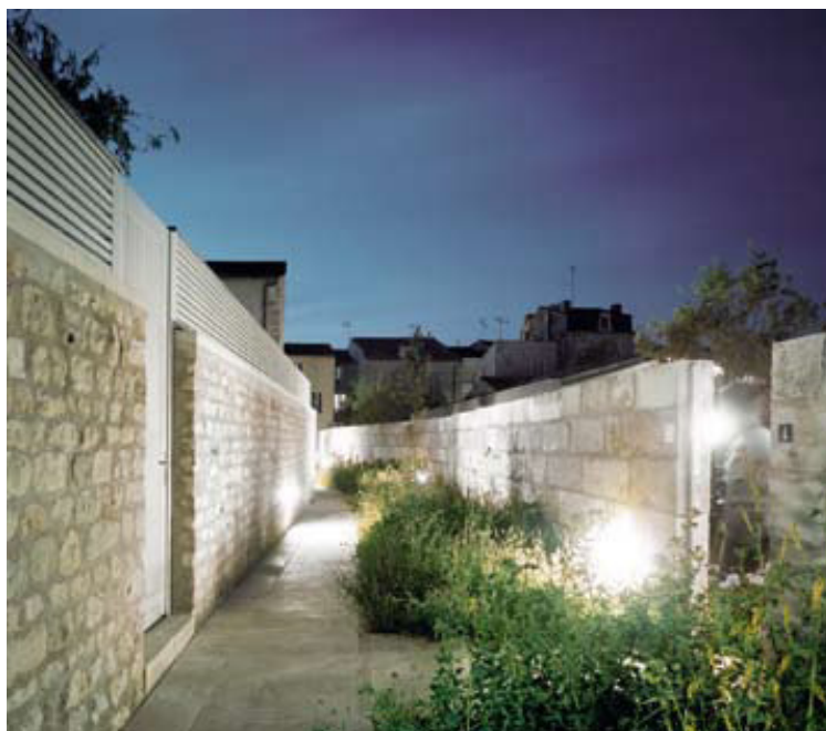
Figure 16 Matériaux des anciennes constructions utilisés pour aménager les cheminements piétons. Source: Visions, 2007. Photo: Ph. Babled Nouvet Reynaud Architectes
