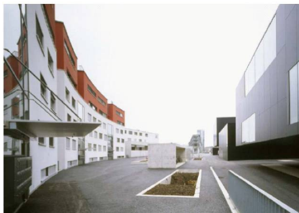
Espaces publics en cours de réalisation (photo Ruedi Walti)
