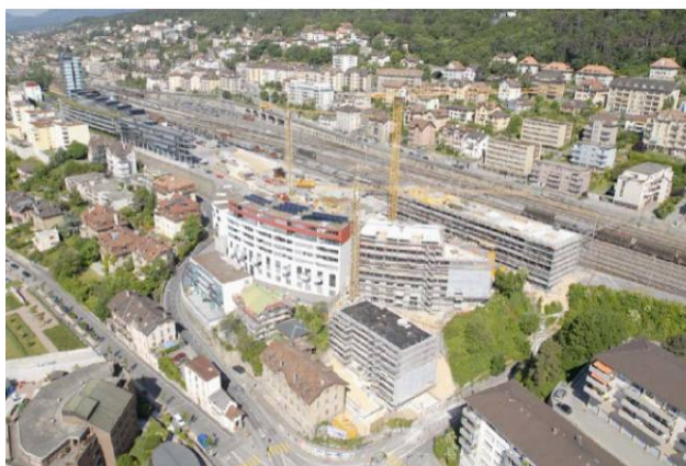
Vue aérienne du chantier en juin 2006 (photo E. Bettinelli)
