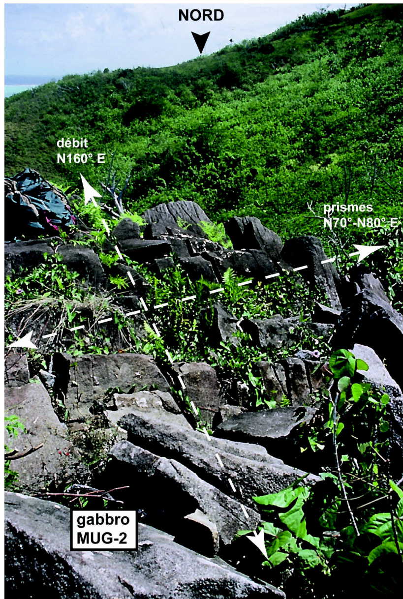
FIG. II.25: Photographie de détail de la fracturation du gabbro du Faataufi au niveau de l'affleurement n°2. L'image montre bien les deux systèmes de fractures: le débit en dalles verticales peu épaisses (fractures orientées N160° E) et la découpe (prismes orientés N70° à N80° E) en prismes presque perpendiculaires au débit.
