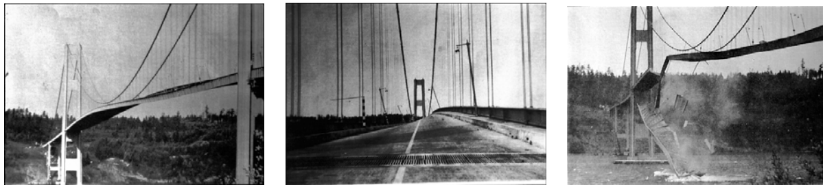
FIG. B.5 – Le 7 novembre 1940, six mois après son inauguration, le pont suspendu de Tacoma (USA) était détruit à cause d'un phénomène de résonance dû aux oscillations en torsion provoquées par le vent. Les rafales n'étaient pas exceptionnelles ce jour là, mais leur cadence coïncidait avec la période d'oscillations du pont. Un film (Ed Elliot The Camera Shop 1007 Pacific Avenue Tacoma, Washington USA 98402) pris par un particulier présent sur les lieux au moment de la catastrophe a permis au monde entier de voir ce phénomène unique. À la suite de ces spectaculaires oscillations forcées de grande amplitude, le centre du pont s'écroule.
