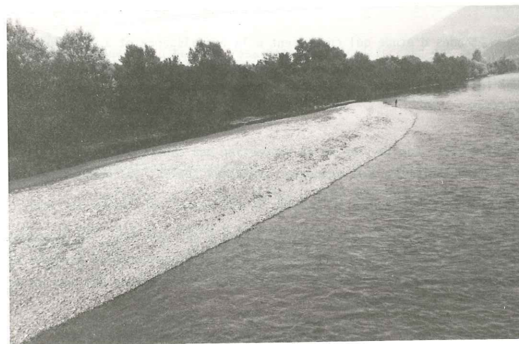
Photo 11. Les travaux effectués à l'amont de Grenoble ont entraîné un enfoncement du lit de l'Isère. Cette vue prise vers le N-E montre un banc de gravier dans le lit mineur, apparu à la suite de cet enfoncement au niveau du pont reliant Tencin à La Terrasse.
