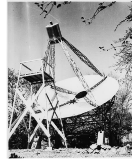
Figure 2.3 – Le télescope de Reber (1937) qui a cartographié l'émission radio de notre Galaxie.
