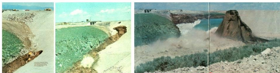
(Barrage de Teton, USA, 1976)
