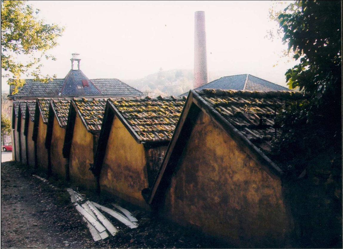
Fig. 69. Les toits de sheds de l'usine du bas à Jungholtz (photo B. Risacher)
