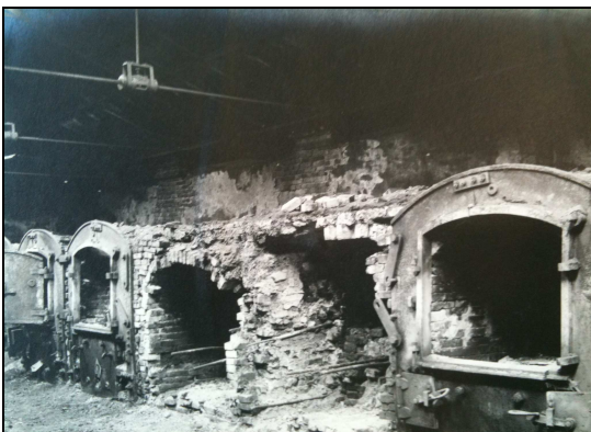
Chaudières chez Latscha & Cie (ADHR PURG 030849)
