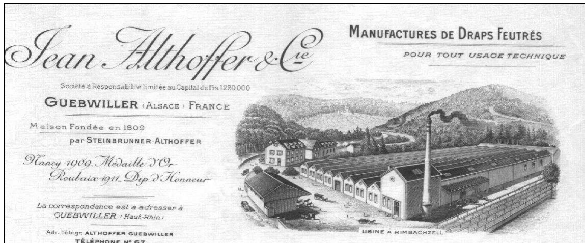
Fig. 63. En-tête de la manufacture Jean Althoffer, (source Philippe Althoffer). L'usine de Rimbach avait une superficie de 3000 m 2 . On voit au 1 er plan à droite les rames qui servaient au séchage et au blanchiment du tissu. Au second plan, à droite, l'usine à toiture en sheds avec, incrustée dans le bâtiment, la centrale vapeur. A gauche, un entrepôt et les écuries. A l'arrière plan, la « Cité », l'habitat collectif des ouvriers. (col. Ph. Althoffer)
