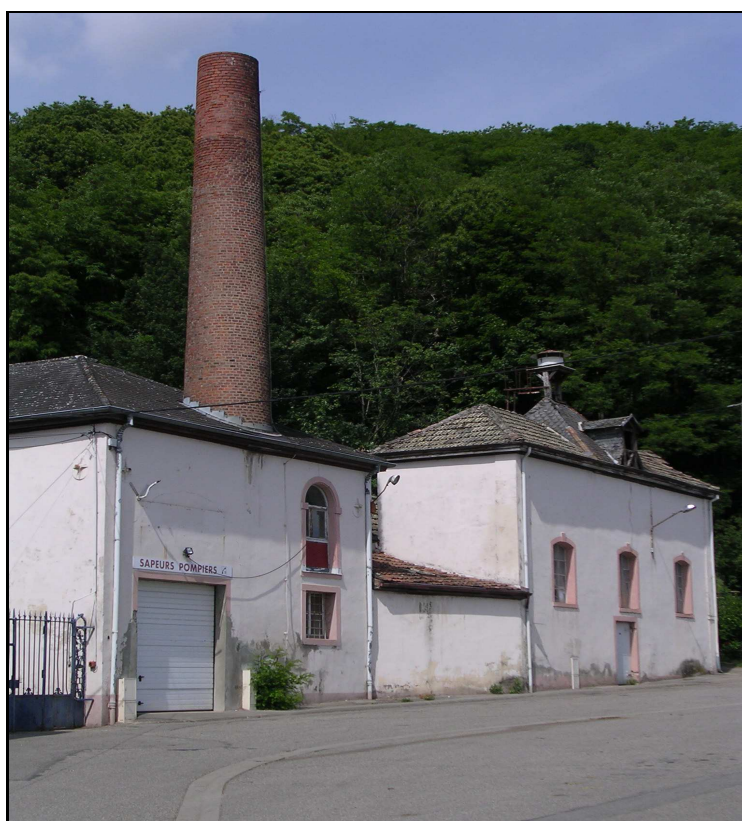
Fig. 04. L'usine du bas à Jungholtz (photo B.Risacher)
