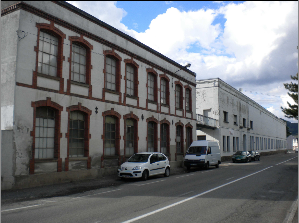
Fig. 71. L'usine-bloc des établissements Baumann Aîné & Cie, un bloc parallélépipédique à couverture plate en terrasse bordée d'un parapet, se caractérise par « l'utilisation massive de la brique [...] comme matériau de base » qui « masque une ossature porteuse de fer et de fonte » et des fenêtres par paires (gémées) « de manière à laisser passer plus de lumière en direction des volumes internes ». On voit apparaître en façade les ancrages des tirants, qui revêtent « une indéniable valeur décorative » (photo B. Risacher)
