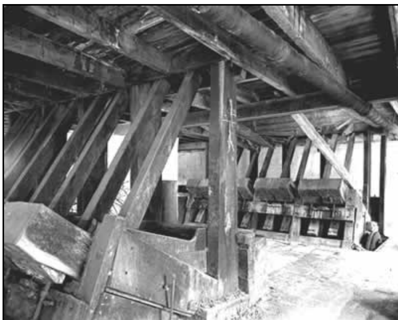
Fig. 19. Dans le moulin à foulon de la chamoiserie Rousseau à Saint-Liguairé subsistent deux lignes de foulons à maillets datant de la fin du XIX e siècle pour l'une et de 1920 pour l'autre, entraînées par une roue hydraulique. Ces machines sont identiques à celles représentées dans l'Encyclopédie de Diderot et d'Alembert. Elles servaient à battre les peaux de manière à ce qu'elles s'imbibent d'huile, et ont été remplacées par des tonneaux dans les années 1970. (photo M. Deneyer).
