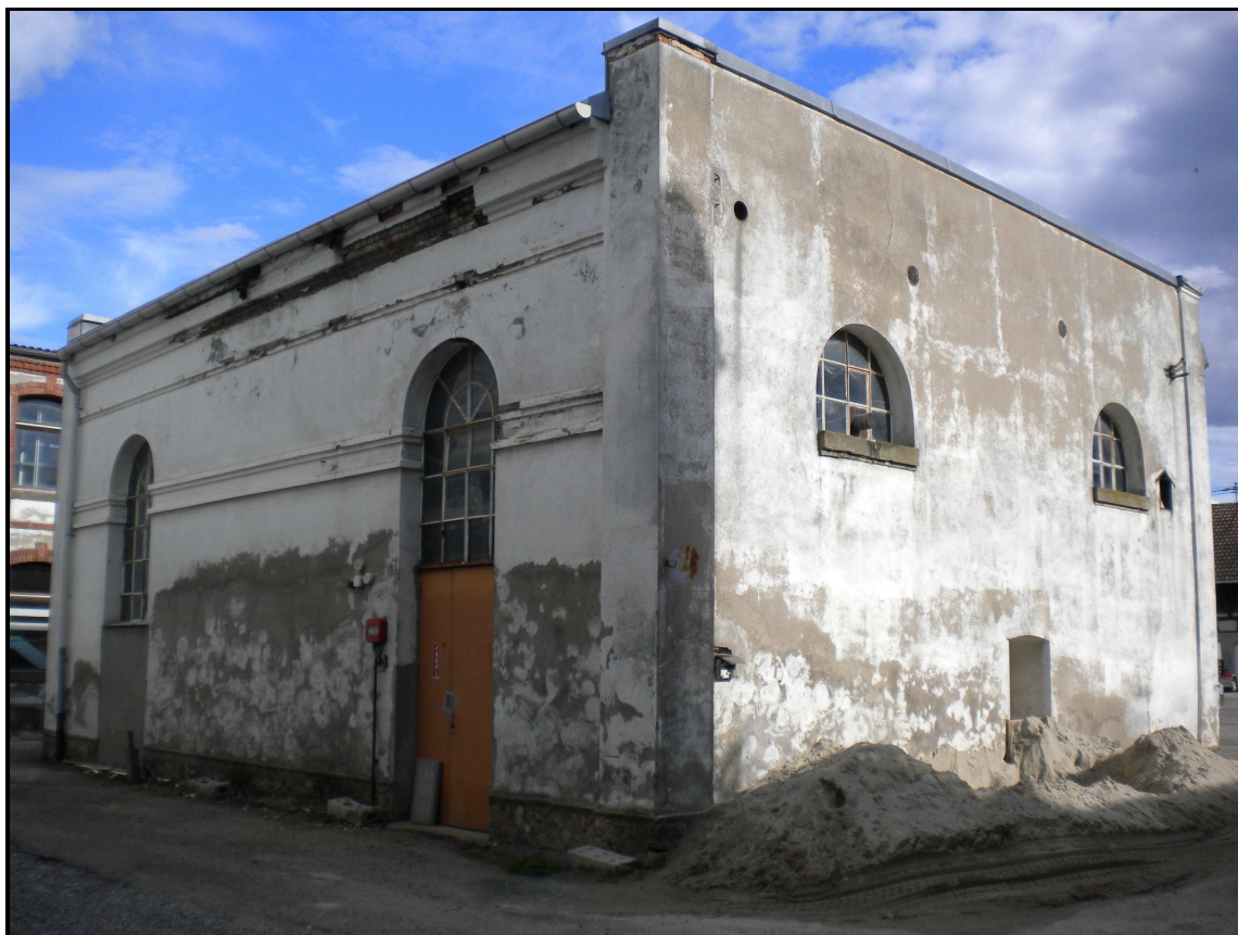
Fig. 74. La centrale d'énergie de la soierie Baumann à Sultz (photo B. Risacher)
