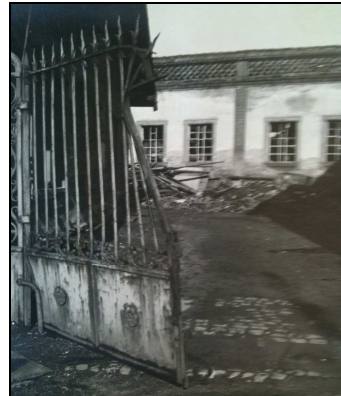
Atelier des broches Latscha & Cie (ADHR PURG 030849)
