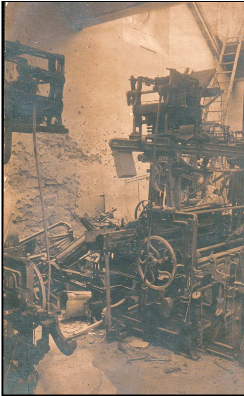
Fig. 98. Vue intérieure du tissage « Baumann Aîné & Cie » après le bombardement du 8 juin 1915 (col. Amis de Soultz)
