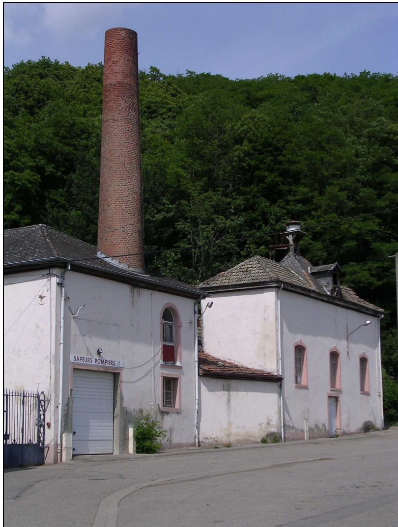
Fig. 73. La halle de la machine à vapeur à l'usine du bas de Jungholtz dominée par la cheminée (photo B. Risacher)
