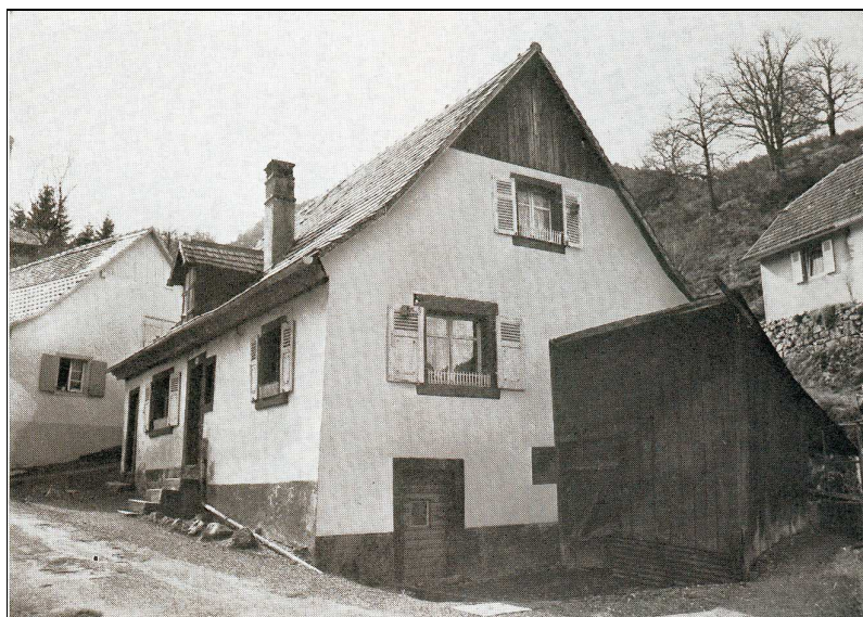
Fig. 85. Maison n°28 rue Principale à Rimbach aujourd'hui. Elle portait la date de 1785 au dessus de la porte d'entrée. L'étable est totalement enterrée et son accès se faisait par la porte d'accès dans le mur pignon. Le logis était situé au même niveau que la cave qui est surmontée d'un fenil. La pointe du pignon est en bois. (photo, Ministère des affaires culturelles, Inventaire général des monuments et des richesses artistiques de la France. Commission régionale d'Alsace. Haut-Rhin. Canton de Guebwiller, Tome 2, Imprimerie Nationale, Paris, 1972, p. 404 ).
