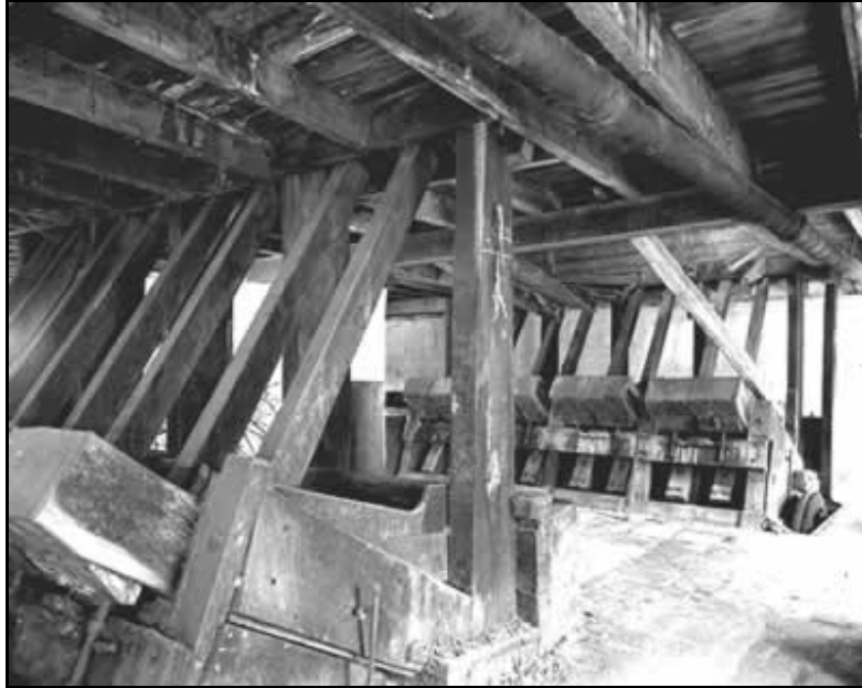
Fig. 19. Dans le moulin à foulon de la chamoiserie Rousseau à Saint-Liguairé subsistent deux lignes de foulons à maillets datant de la fin du XIX e siècle pour l'une et de 1920 pour l'autre, entraînées par une roue hydraulique. Ces machines sont identiques à celles représentées dans l'Encyclopédie de Diderot et d'Alembert. Elles servaient à battre les peaux de manière à ce qu'elles s'imbibent d'huile, et ont été remplacées par des tonneaux dans les années 1970. (photo M. Deneyer).
