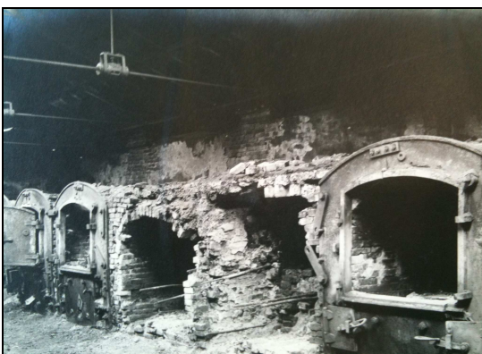
Chaudières chez Latscha & Cie (ADHR PURG 030849)
