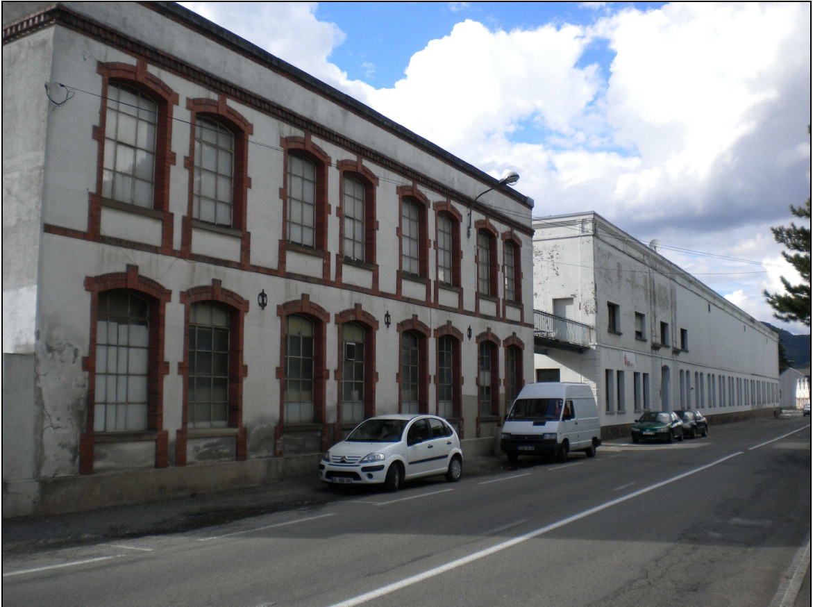
Fig. 71. L'usine-bloc des établissements Baumann Aîné & Cie, un bloc parallélépipédique à couverture plate en terrasse bordée d'un parapet, se caractérise par « l'utilisation massive de la brique [...] comme matériau de base » qui « masque une ossature porteuse de fer et de fonte » et des fenêtres par paires (gémées) « de manière à laisser passer plus de lumière en direction des volumes internes ». On voit apparaître en façade les ancrages des tirants, qui revêtent « une indéniable valeur décorative » (photo B. Risacher)
