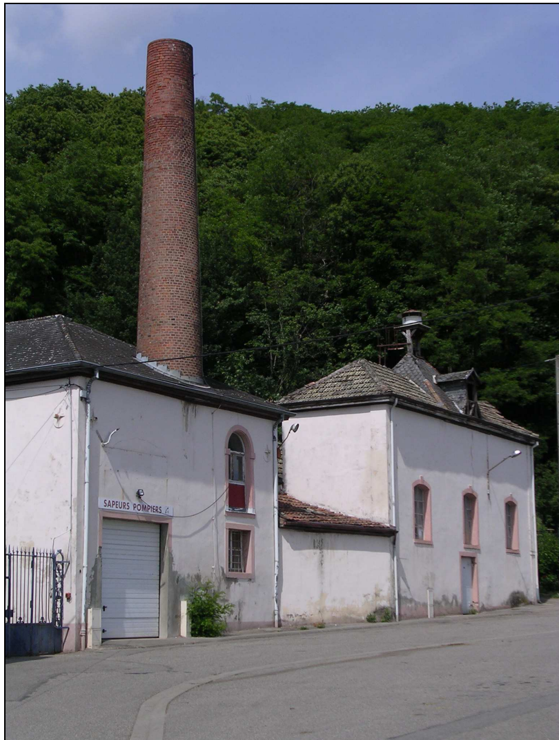
Fig. 73. La halle de la machine à vapeur à l'usine du bas de Jungholtz dominée par la cheminée (photo B. Risacher)
