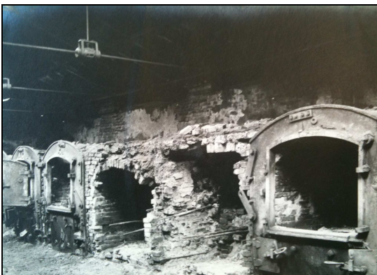
Chaudières chez Latscha & Cie (ADHR PURG 030849)
