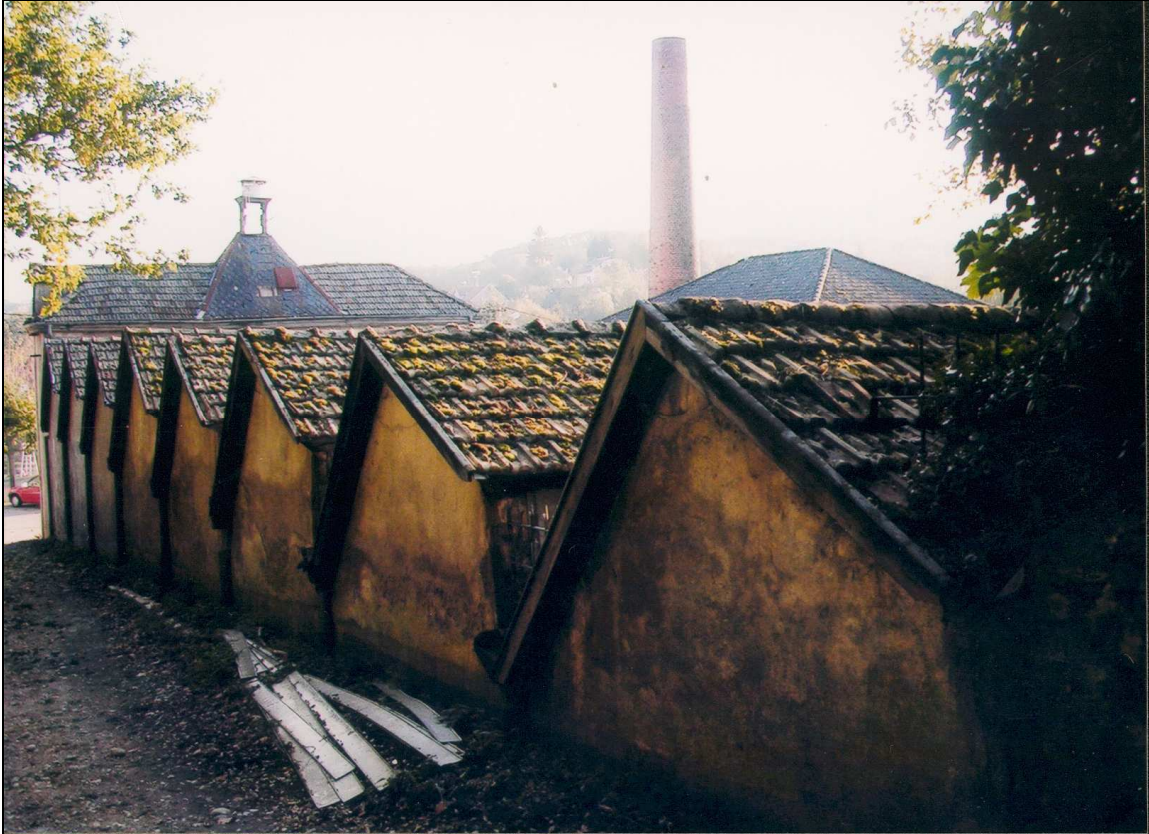
Fig. 69. Les toits de sheds de l'usine du bas à Jungholtz (photo B. Risacher)
