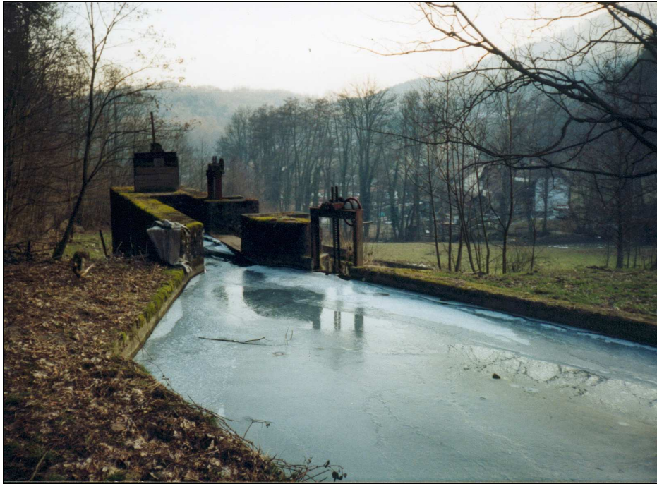
Fig. 79. Le canal d'amenée de l'entreprise Althoffer à Rimbach-Zell (photo B. Risacher)
