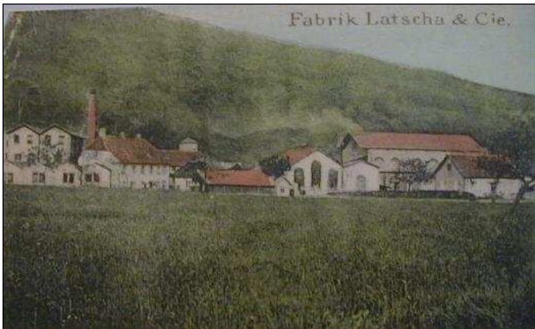
Fig. 48. Latscha & Cie : l'usine centrale (col. B. Risacher)
