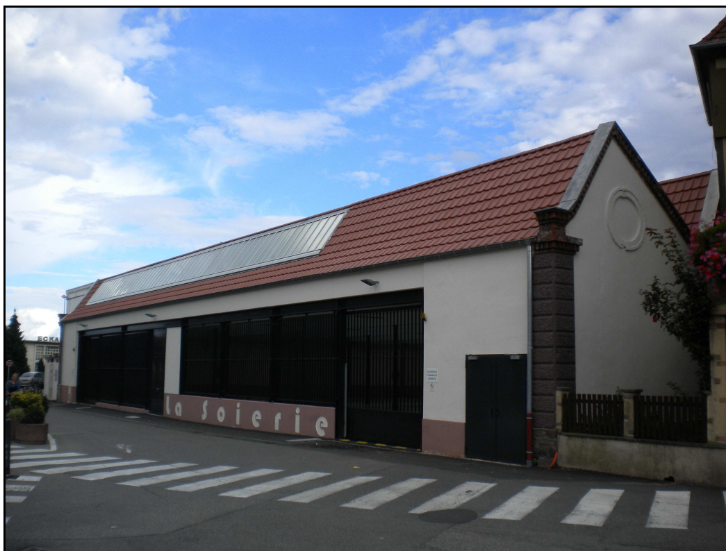
Fig. 111. Une réhabilitation réussie. L'ancienne friche industrielle de la soierie Baumann Aîné & Cie transformée en marché couvert (photo B. Risacher)
