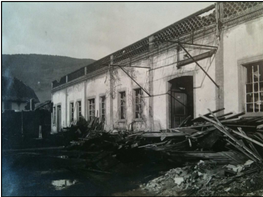
Atelier des broches Latscha & Cie (ADHR PURG 030849)
