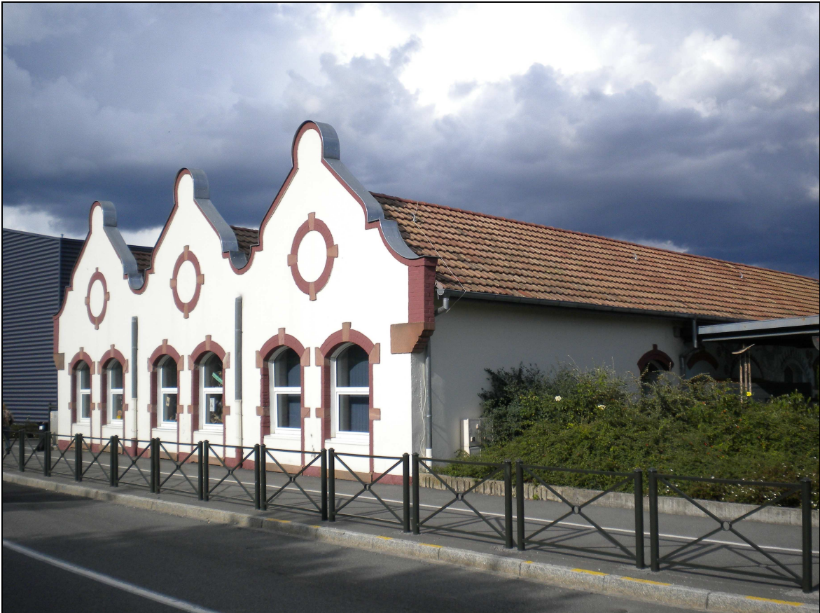
Fig. 70. Façade de la Manufacture Alsacienne de Broches (MAB) anciennement les « Fils d'Edouard Latscha » à Soultz (photo B. Risacher).
