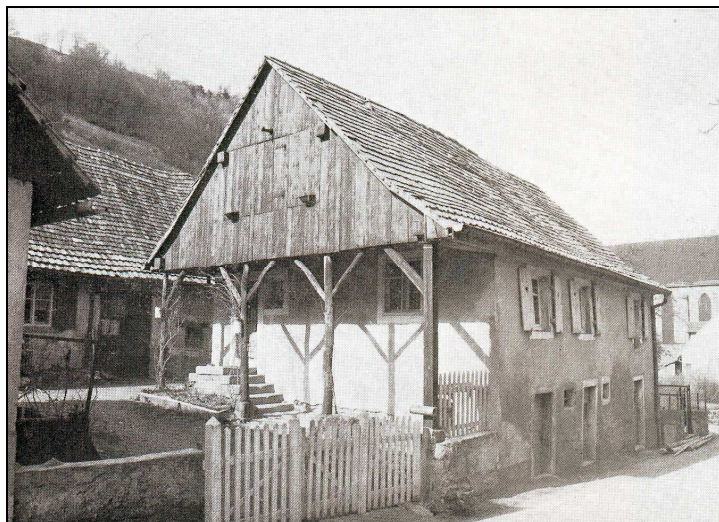
Fig. 83. Maison n°20 rue Principale à Rimbach. La cave et l'étable se trouvent dans l'étage en soubassement et le logement en rez-de-chaussée surélevé. Dans le comble se trouvait le fenil en avancée sur le mur pignon. Le pignon tout entier est en pan de bois lambrissé de planches. (photo, Ministère des affaires culturelles, Inventaire général des monuments et des richesses artistiques de la France. Commission régionale d'Alsace. Haut-Rhin. Canton de Guebwiller , Tome 2, Imprimerie Nationale, Paris, 1972, p. 404).
