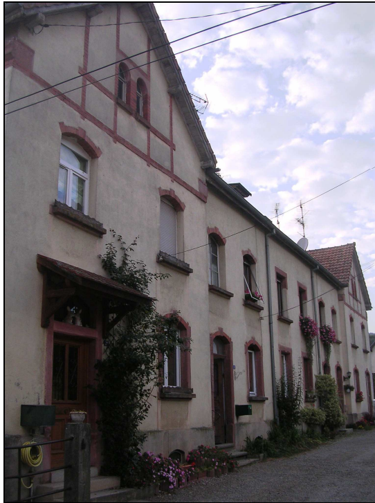
Fig. 91. Le « Kassahus », habitat collectif de huit appartements fait de briques. On peut remarquer en façade le faux colombage en briques qui orne les pignons (photo, B. Risacher)
