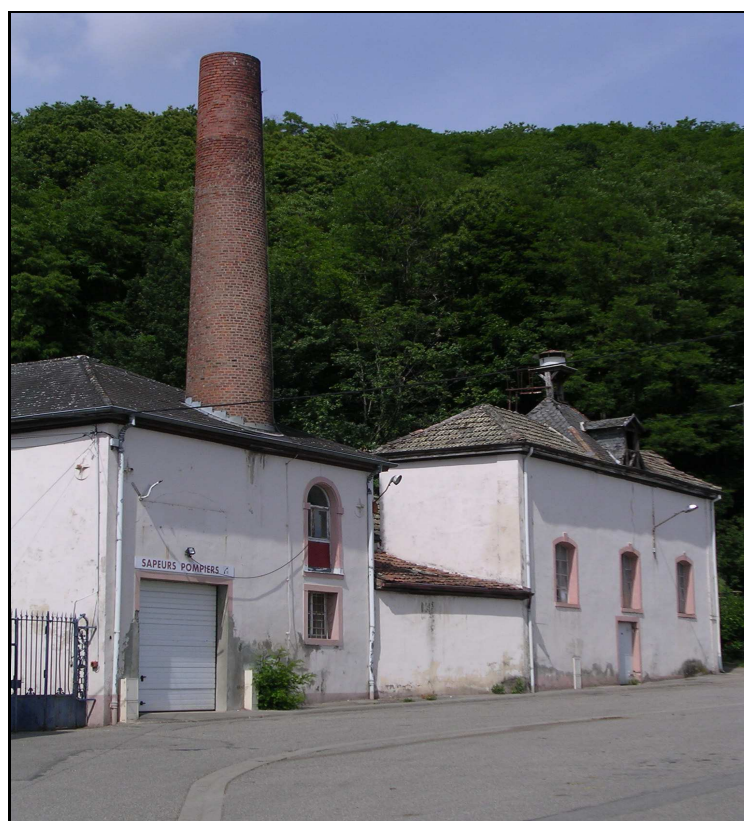
Fig. 04. L'usine du bas à Jungholtz (photo B.Risacher)
