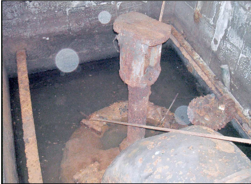
Fig. 77. La turbine horizontale dans le site de l'usine du bas à Jungholtz (photo B. Risacher)
