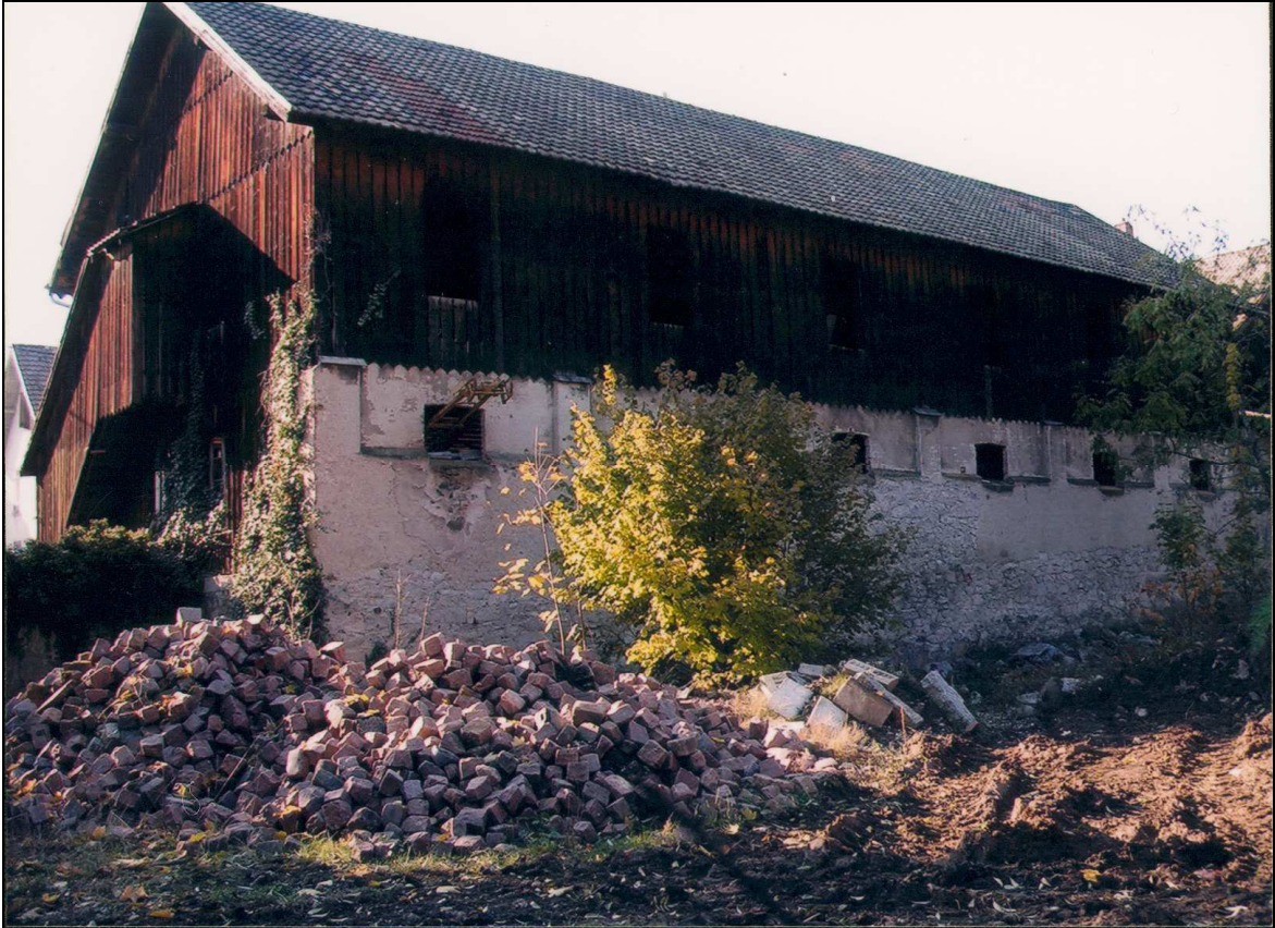
Fig. 72. Hangar industriel à Jungholtz qui servait à stocker les moules et autres matières premières ainsi que les produits finis (photo B. Risacher)
