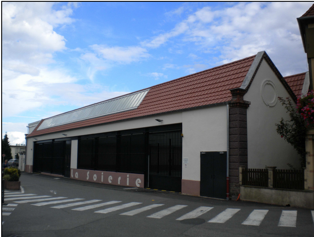
Fig. 111. Une réhabilitation réussie. L'ancienne friche industrielle de la soierie Baumann Aîné & Cie transformée en marché couvert (photo B. Risacher)
