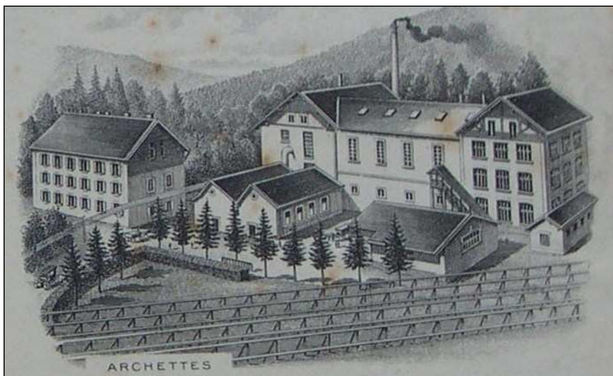
Fig. 65. Détail de l'en-tête de la manufacture Jean Althoffer. L'usine de Haute Moselle avait une superficie de 2000 m 2 . Il s'agit donc d'une unité assez modeste. On voit au 1 er plan les rames qui servaient au séchage et au blanchiment du tissu. Au second plan, à gauche, devant le bâtiment qui devait servir d'habitat ouvrier (une caserne), coule un canal d'amenée débouchant sur une turbine. Il devait également y avoir une machine à vapeur signalée par une cheminée. A l'arrière plan l'unité principale. (col. Ph. Althoffer)
