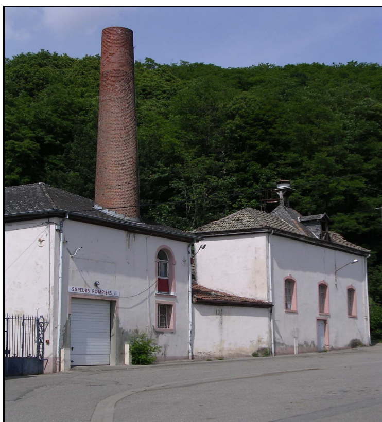
Fig. 04. L'usine du bas à Jungholtz (photo B.Risacher)
