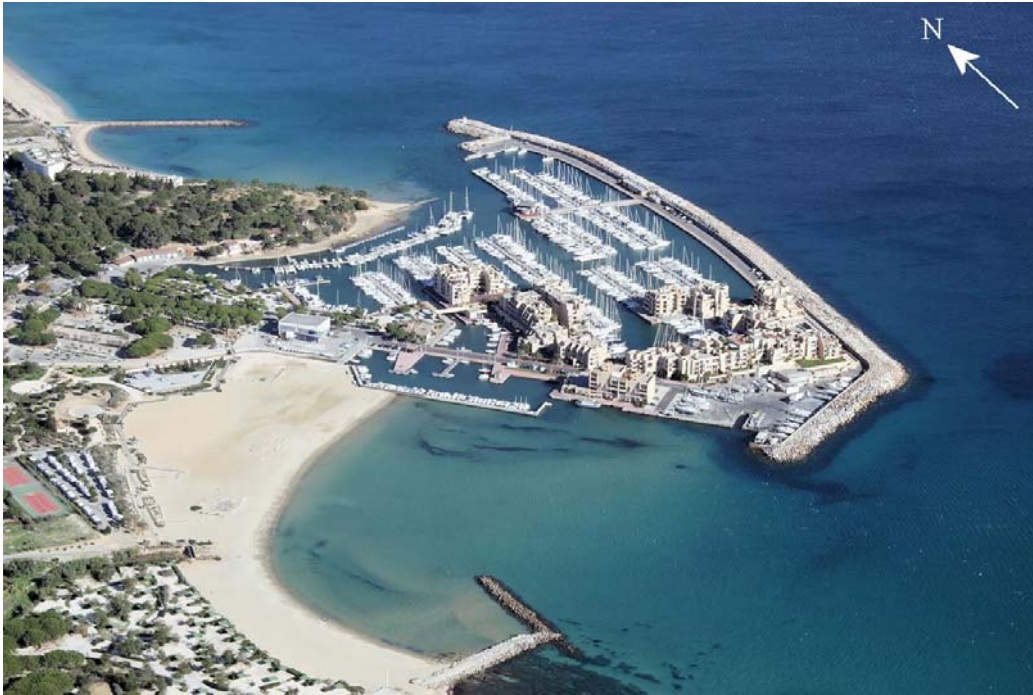
FIG VI.4 – Photo aérienne du Port de Bormes-les-Mimosas
