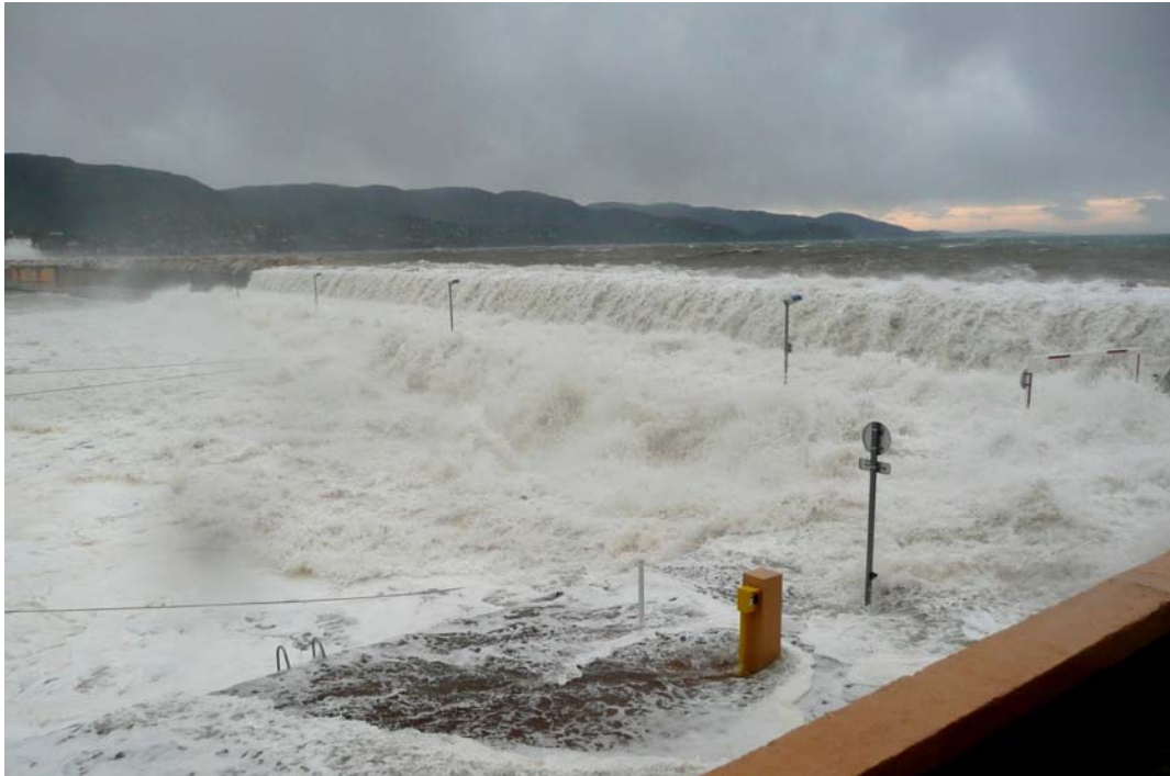
FIG VI.5 – Photo de franchissement au-dessus de la digue du port de Bormes-les-Mimosas
