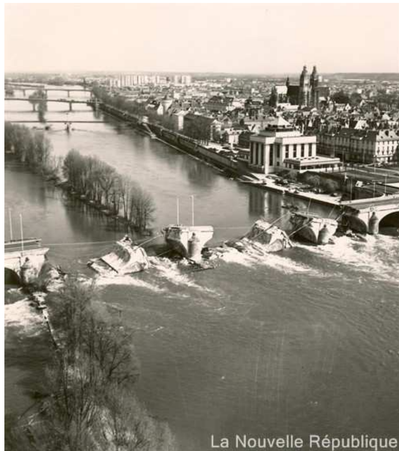
FIGURE 2.13 – Effondrement du pont Wilson à Tours (source : La Nouvelle République, décembre 1978).
