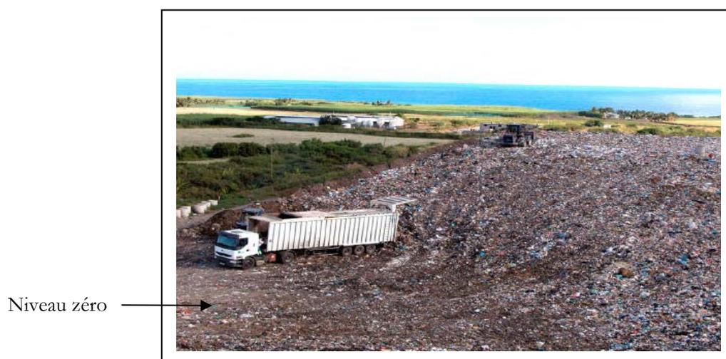
**Figure I.4 :** Alvéole pleine et sur exploitée
