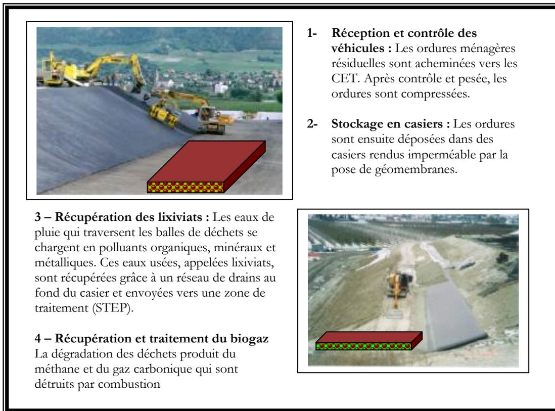
**Figure I.2 : Principe de stockage des ordures ménagères dans les CET**
