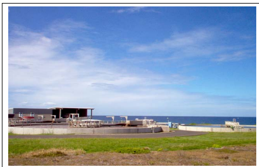
Figure II.49 : La station d'épuration de Pierrefonds
