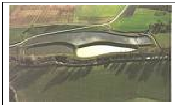
Figure I.1 : Lagunage des eaux résiduaires
