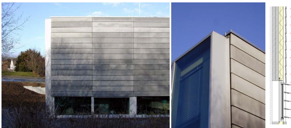
FIG. 2.26 – Façade de l'extension du hall d'essai de l' Institute of Structural Concrete de l'Université d'Aix-la-chapelle, Allemagne
