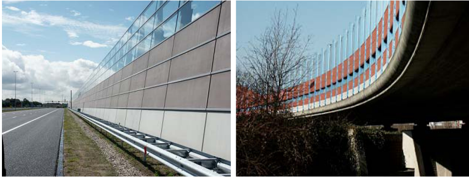
FIG. 2.28 – a) Autoroute de liaison entre Paris et Amsterdam. b) Ponts près de l’aéroport de Düsseldorf, Allemagne
