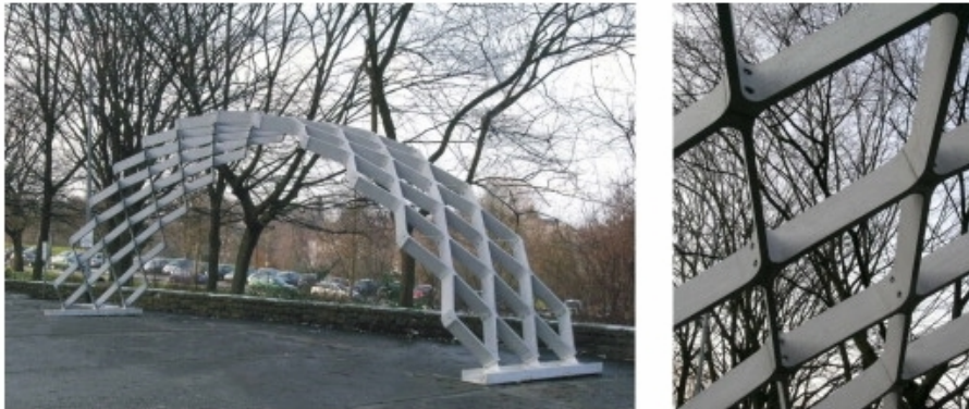
FIG. 2.29 – Structure par assemblage d’éléments rhombiques
