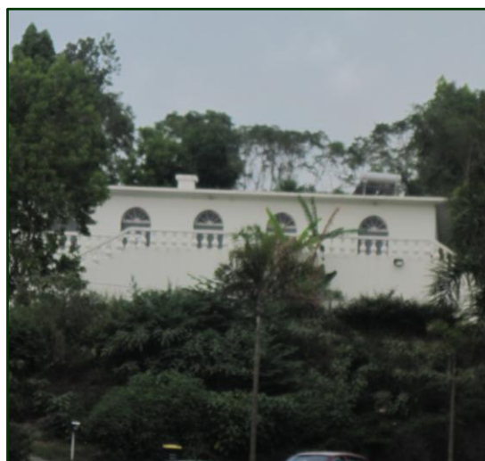
Figure 63 Église Hosanna, le Tampon
