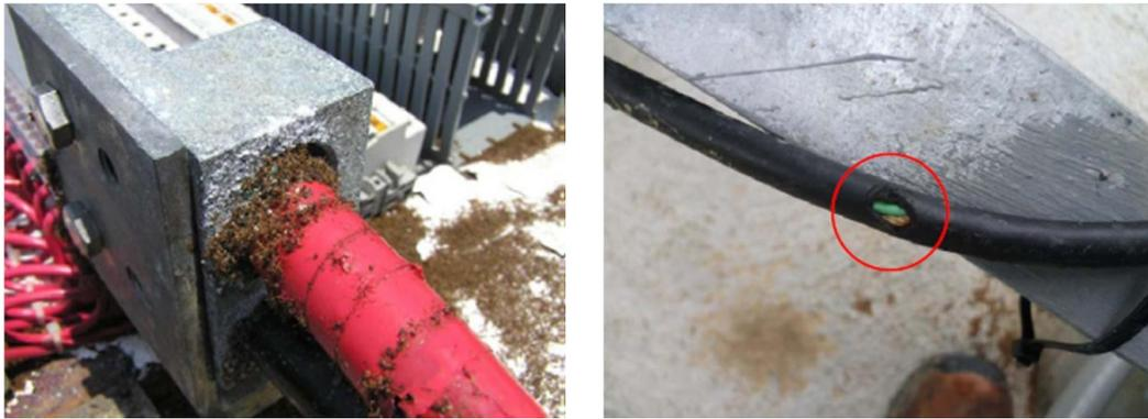
Figure A-3 : Exemples de défauts rencontrés dans le système de câblage
