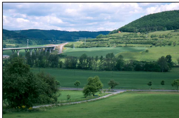
Entrée du parc – Sortie d'autoroute en aménagement (2005)
