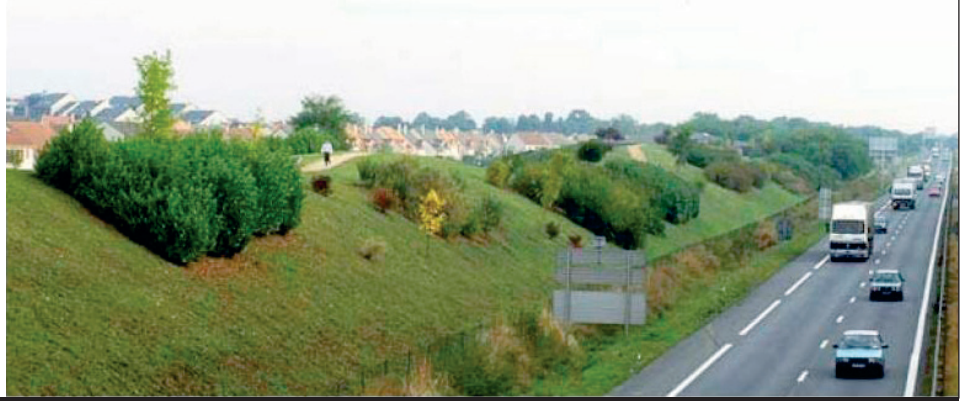
Insertion paysagère végétalisée du talus de protection acoustique le long de l'A 104
