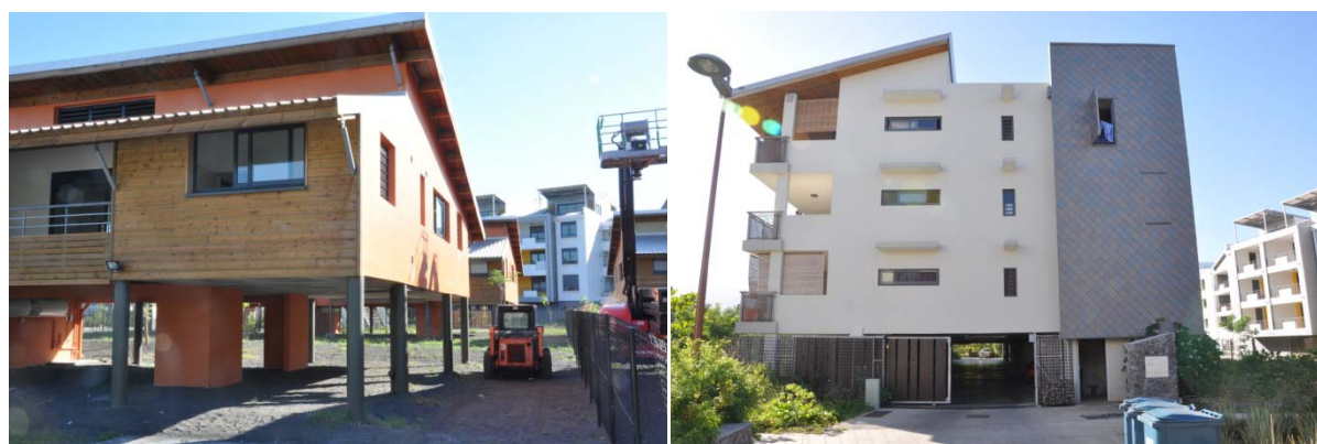
Figure 66. Habitat récent (individuel et collectif) construit sur pilotis à Saint-Paul (La Réunion).
