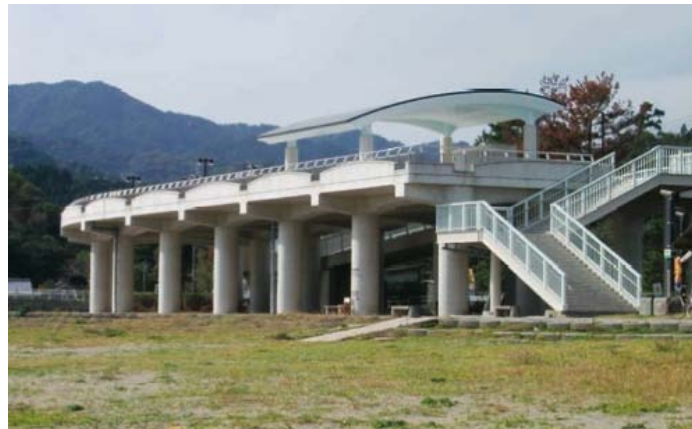
Figure 26. Exemple de zone refuge à usage unique.
