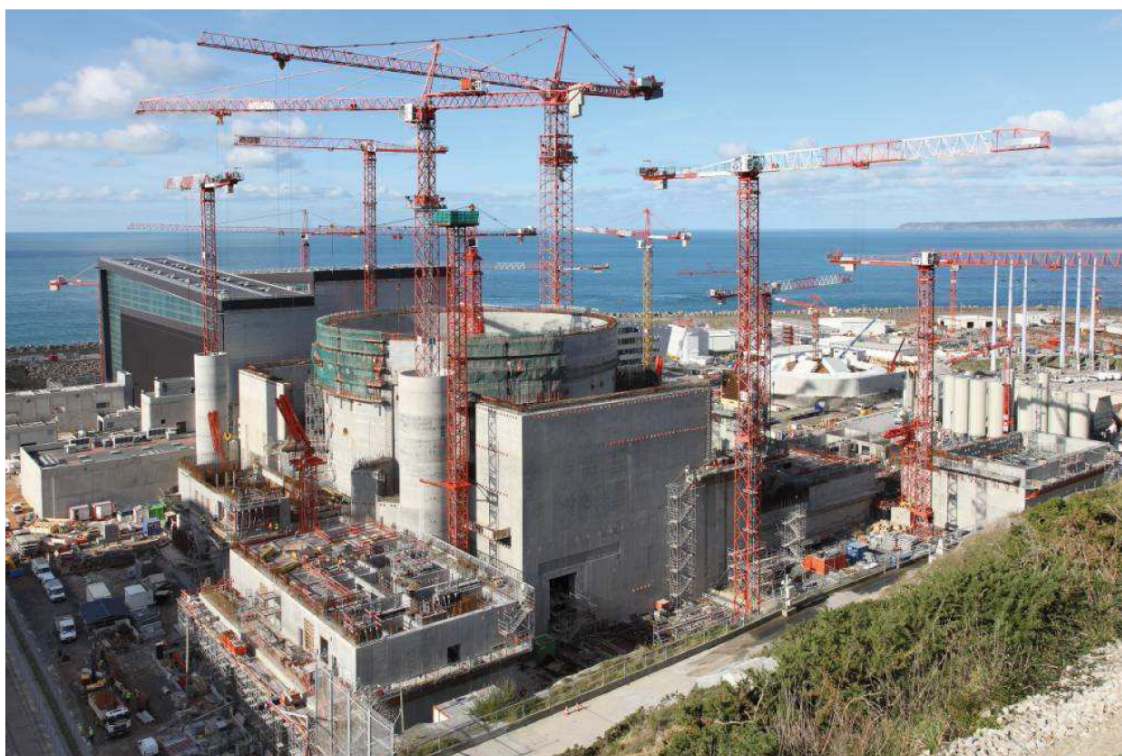
FIG. 8. – Vue générale du chantier de Flamanville 3, en octobre 2010 (crédit EDF).
