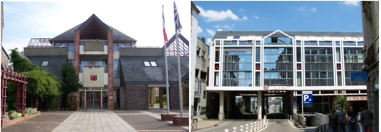
Ill. 170. Bruz, hôtel de ville, façade principale donnant sur le parvis, A. Le Page (1988). Ill. 171. Vannes, annexe de l'hôtel de ville, façade principale, Y. Guillou (1990).
