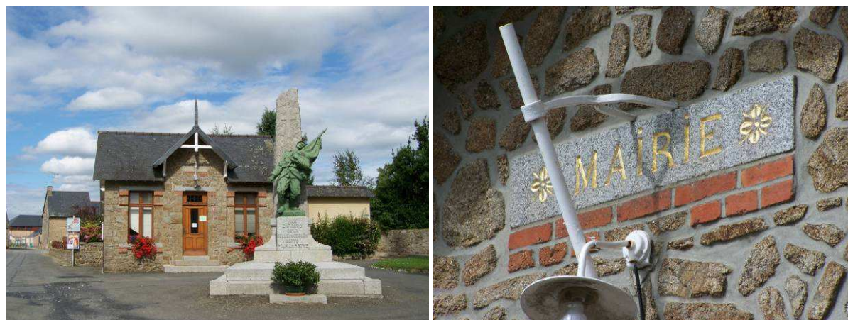
La façade du pavillon municipal et le monument aux morts ; détail du cartouche central
