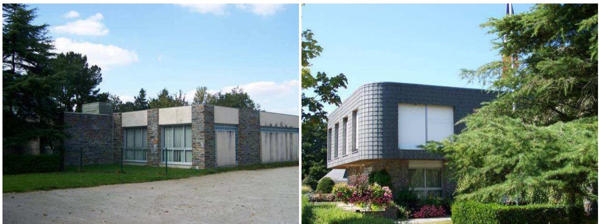
Vue latérale-arrière des services municipaux, côté parking ; détail du pignon
