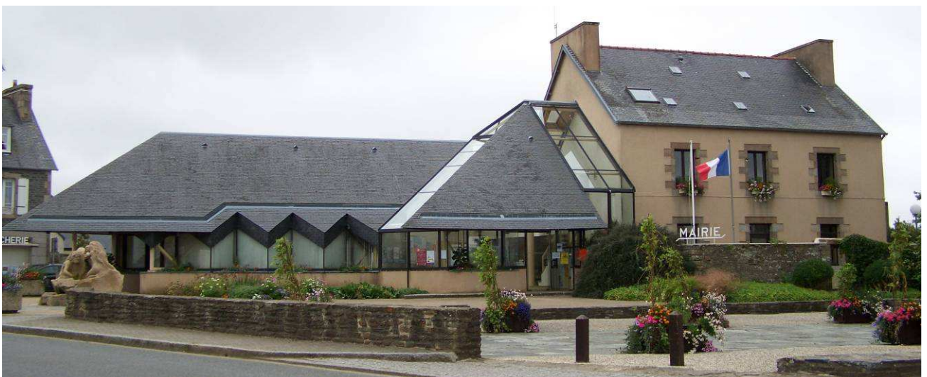
Ill. 172. Taulé, mairie, T. Mostini (1983-1984). L'extension contemporaine de la mairie est greffée à l'ancien presbytère par un interstice de verre.
