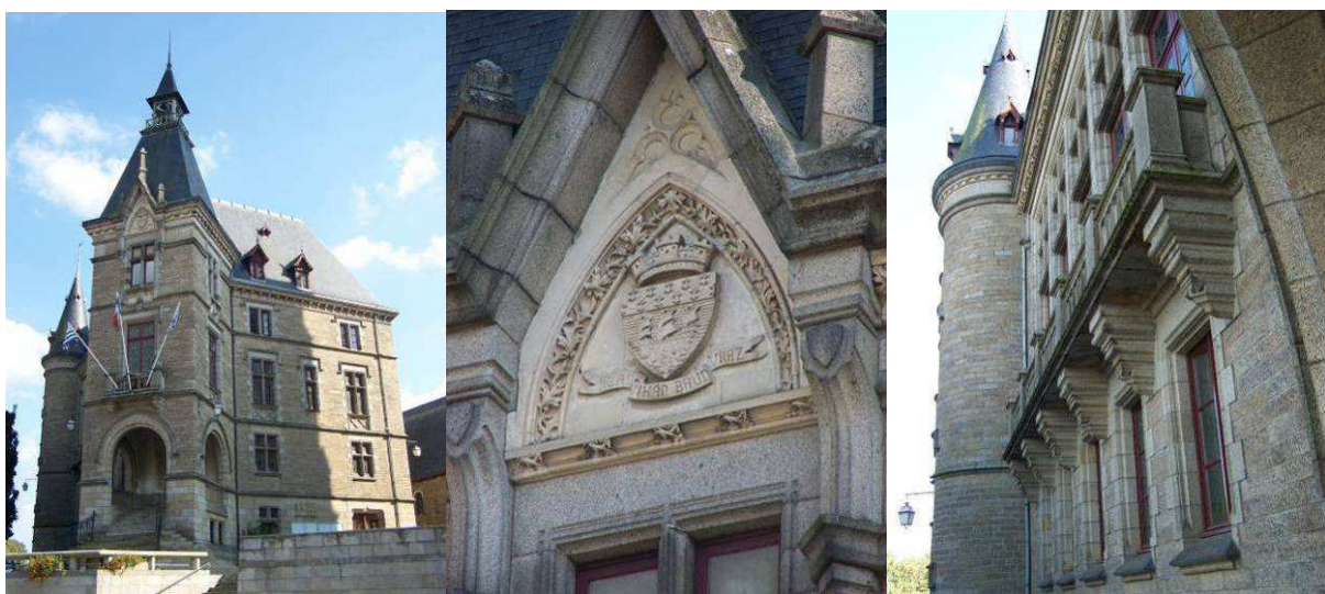
Vue d'ensemble et détails de la façade principale
