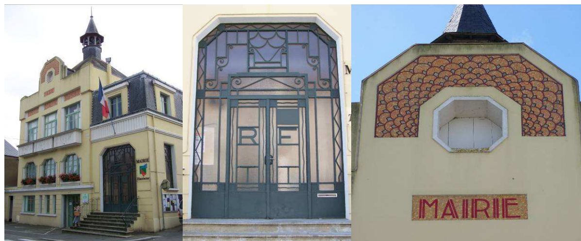
Façade sur la rue ; détail du portail d'entrée ; détail de la mosaïque du fronton
