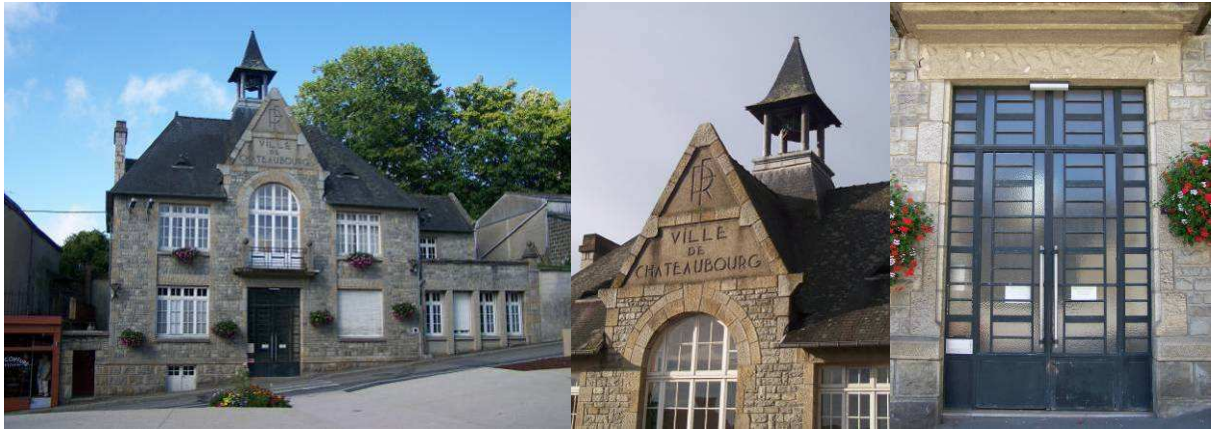
Façade sur la place de l'église ; détail du fronton ; portail d'entrée
