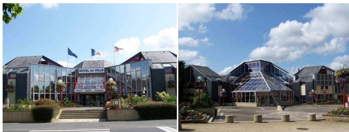
Façades principale et postérieure
