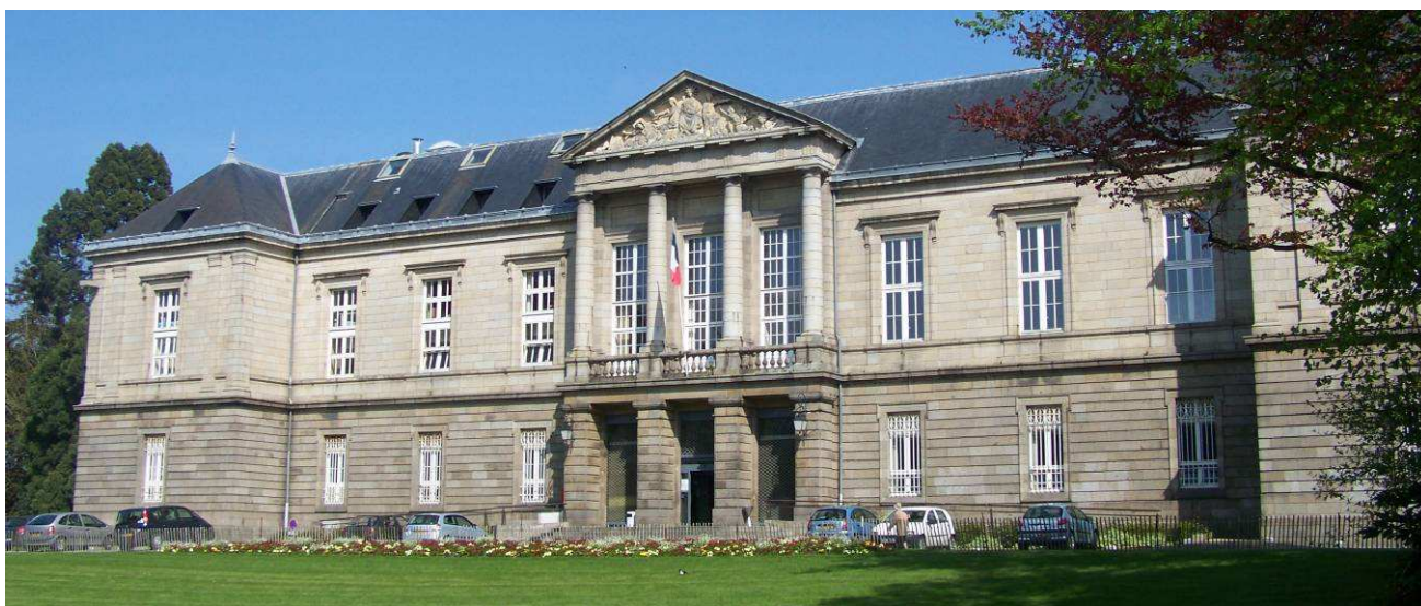
Ill. 68. Saint-Brieuc, tribunal de grande instance, façade donnant sur les jardins, A. Guépin (1862-1865).
