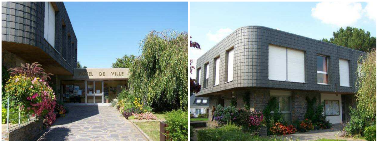
Entrée principale de la mairie, vue sur la rue ; détail du pignon de la perception (rez-de-chaussée) et du logement du percepteur (étage)
