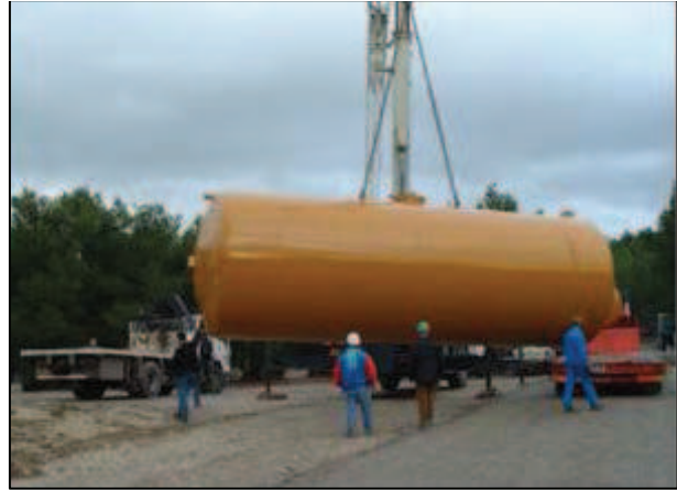
Fig. 70 : Pose d'une citerne
