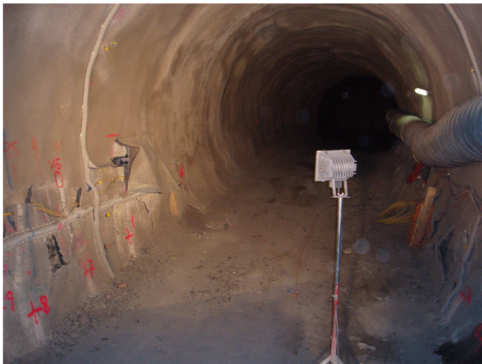
FIG. 6.10 – Etat de la galerie 04 après reprise du creusement (Septembre 2004).
