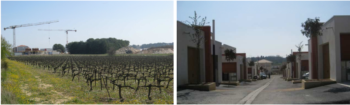
Figure 50 : Construction de lotissements aux abords des parcelles de vignes au nord-est de Montpellier (Commune de Jacou)
