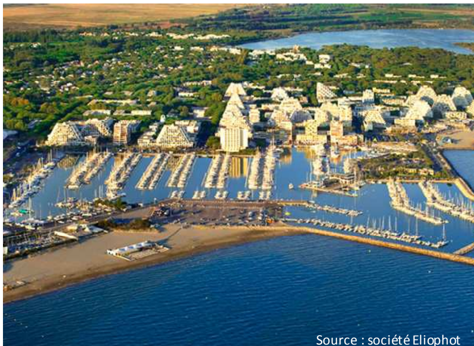
Figure 41 : Station balnéaire de la Grande Motte
