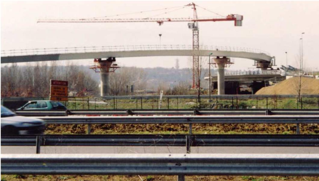
*Le « toboggan » en construction, il permet de glisser directement de la rocade vers Labège, grâce à lui l'échangeur va moins faire figure de goulot d'étranglement.*
