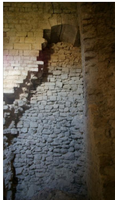
Fig. n° 82. Arc de la porte ouverte à l'étage de la « tour de l'évêque », visible uniquement de l'intérieur (cl. M. Varano).
