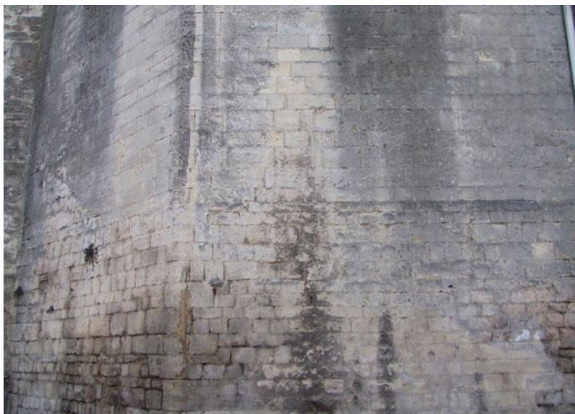
Fig. n° 94. Différence dans le parement de deux pans du chevet de Notre-Dame : la partie supérieure, correspondant aux jours gothiques, est plus soignée (cl. M. Varano).
