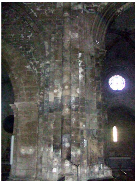
Fig. n° 95. Pilier nord reliant la nef à la croisée du transept (cl. M. Varano).
