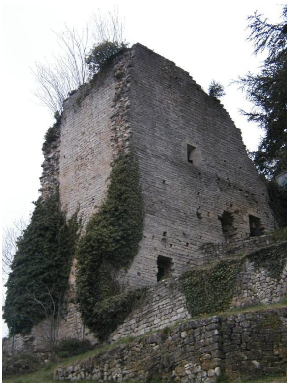
Fig. n° 71. « Tour de l'évêque », vue du nord-est (cl. M. Varano).
