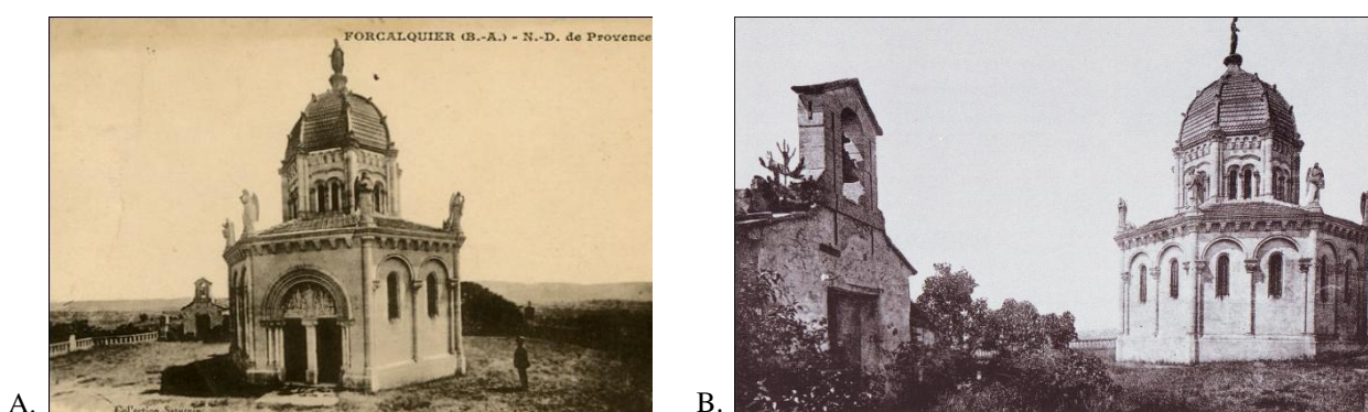
Fig. n° 88. A. Carte postale montrant en premier plan Notre-Dame de Provence et sur l'arrière, la chapelle provisoire (ADAHP, AD 04-2Fi2738). B. La chapelle provisoire et Notre-Dame de Provence, vues du nord-est (J.-Y. Royer, Forcalquier, 1986).
