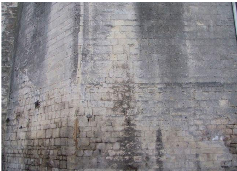
Fig. n° 94. Différence dans le parement de deux pans du chevet de Notre-Dame : la partie supérieure, correspondant aux jours gothiques, est plus soignée (cl. M. Varano).
