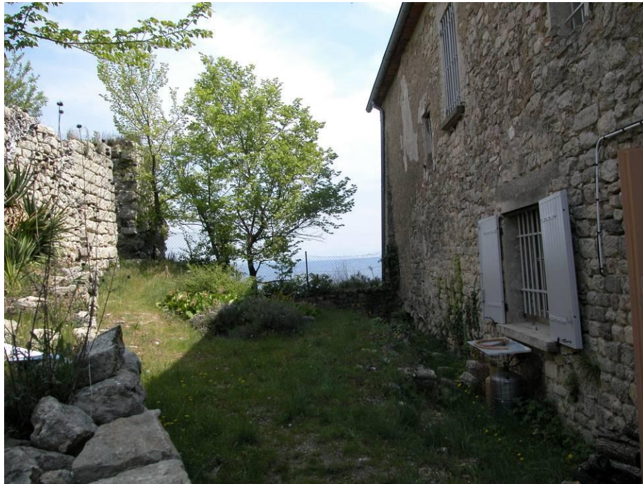
Fig. n° 154. Espace compris entre la façade nord du logis et l'axe défini par les murs 15, 19 et 16, vu de l'ouest (cl. M. Varano).
