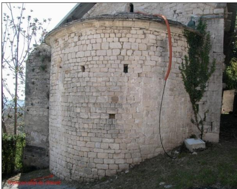
Fig. n° 106. Chevet de Saint-Saint vu du nord-est : le tronçon de mur au tracé plat est indiqué par la flèche rouge (cl. M. Varano).
