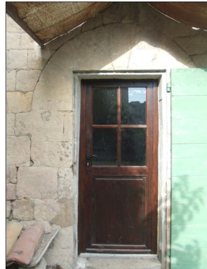
Fig. n° 127. Traces de la porte ouverte sur la façade occidentale du bâtiment annexe à l'église Saint-Promasse (cl. M. Varano).
