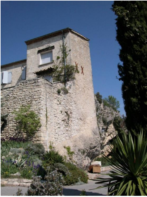
Fig. n° 167. Tour A, vue du sud-est (cl. M. Varano).
