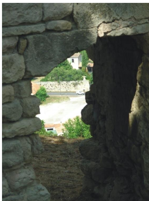
Fig. n° 78. A. Archère à ébrasement oblique percée sur le mur nord de la pièce A, vue du nord. B. Archère vue de l'intérieur de la pièce A : en arrière plan, le mur délimitant à l'ouest la cours du prieuré de Saint-Promasse (cl. M. Varano).
