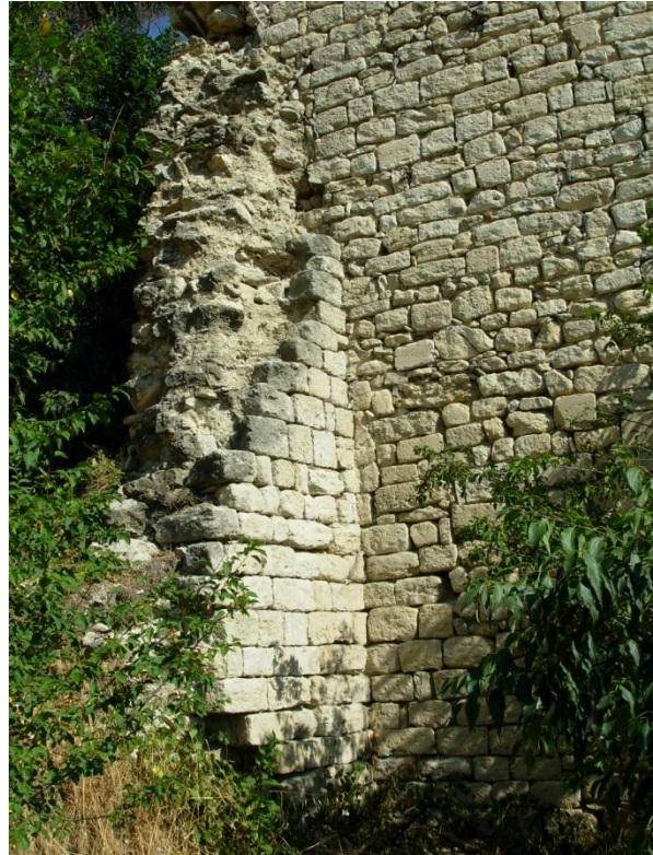
Fig. n° 75. Mur oriental de la pièce A arraché vers le sud A. B. Détail du chaînage entre les murs des deux volumes (cl. M. Varano).
