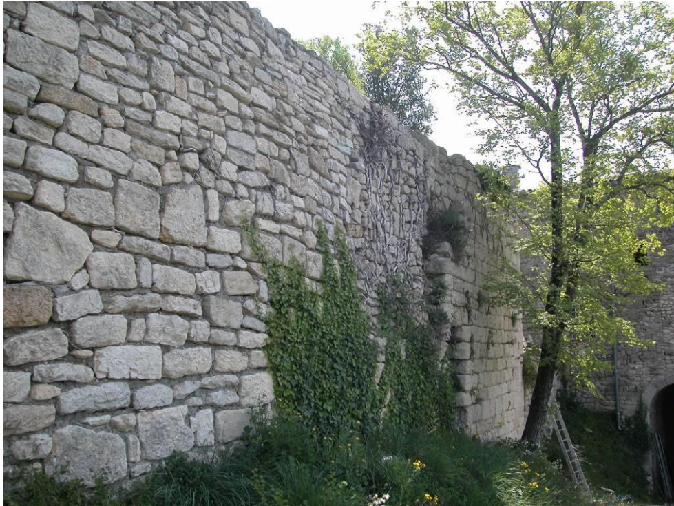
Fig. n° 152. Mur 19 et, sur le fond, mur 16 (cl. M. Varano).
