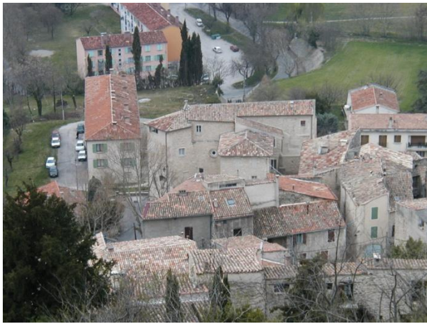
Fig. n° 120. Vue du mur percé d'un oculus correspondant à la façade de l'église détruite Saint-Pierre (cl. M. Varano).
