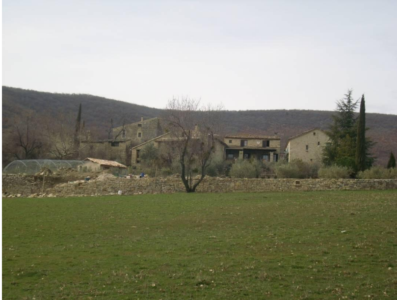
Fig. n° 214. Le hameau des Ybourgues vu de la route d'accès actuelle, à l'est (cl. M. Varano).
