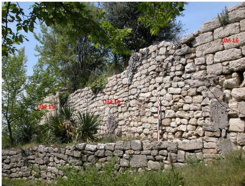
Fig. n° 182. Les murs 15 et 16 séparés par le mur postérieur UM 19 (cl. M. Varano).
