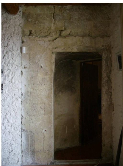
Fig. n° 172. Porte s'ouvrant sur le mur 24 et donnant accès à la tour A (cl. M. Varano).
