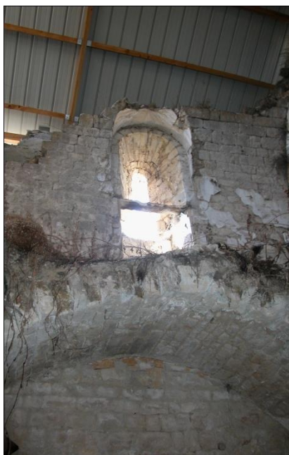
Fig. n° 111. Première travée de Saint-Jean : fenêtre à double ébrasement au-dessus de la voûte de la tribune (cl. M. Varano).
