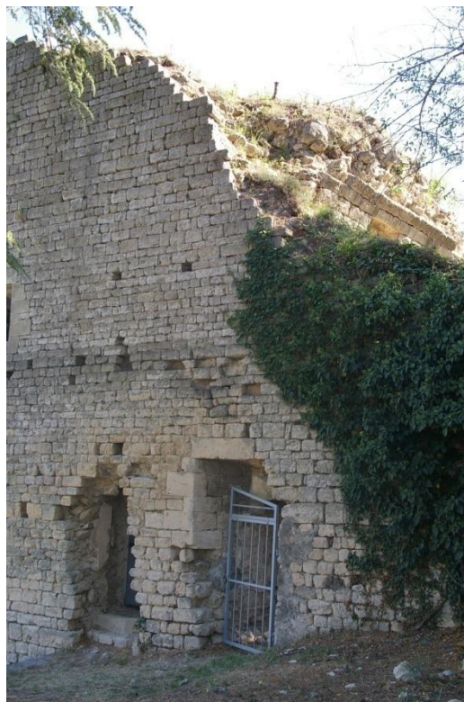
Fig. n° 83. Tour vue du nord avec son élévation. À droite, départ de la voûte de la pièce A (cl. M. Varano).
