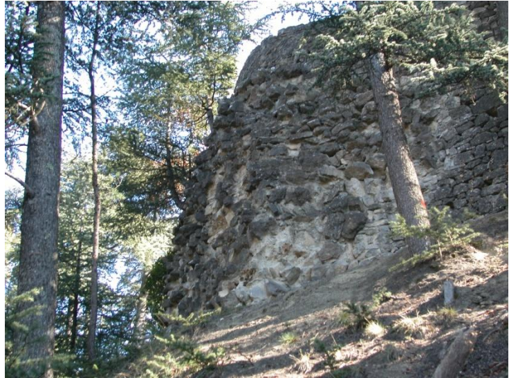
Fig. n° 84. Massif de blocage situé immédiatement au nord du rocher de la citadelle, pouvant constituer le vestige d'une tour disparue (cl. M. Varano).
