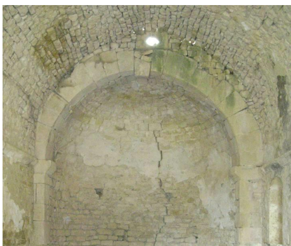
Fig. n° 58. Église de la Conseillère à Vachère. A. Ébrasement asymétrique intérieur du jour percé sur la façade méridionale. B. Arc triomphal et cul-de-four de l'abside (cl. M. Varano).
