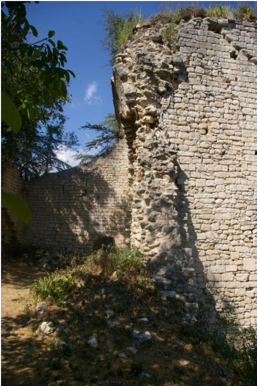
Fig. n° 75. Mur oriental de la pièce A arraché vers le sud A. B. Détail du chaînage entre les murs des deux volumes (cl. M. Varano).
