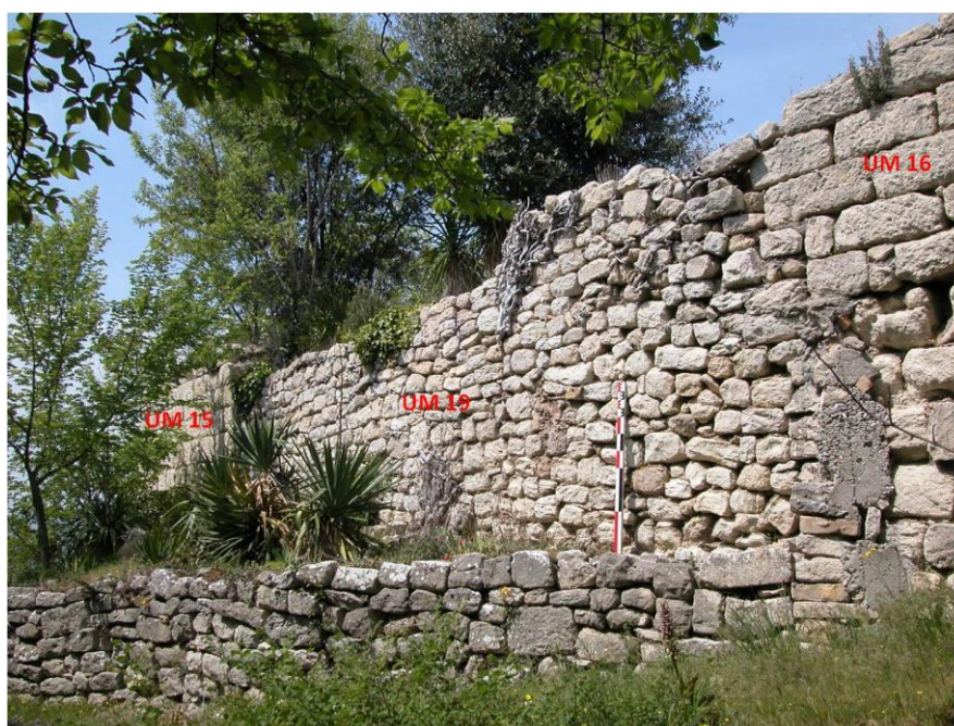
Fig. n° 153. Aperçu des murs 15, 19 et 16, vus du sud-est (cl. M. Varano).
