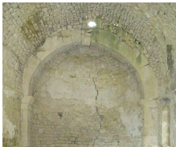
Fig. n° 58. Église de la Conseillère à Vachère. A. Ébrasement asymétrique intérieur du jour percé sur la façade méridionale. B. Arc triomphal et cul-de-four de l'abside (cl. M. Varano).
