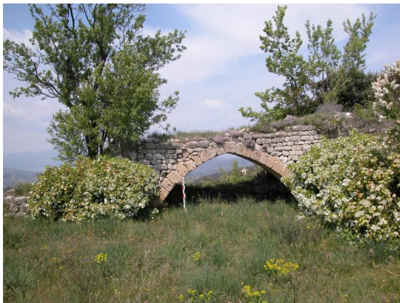
Fig. n° 181. Arc du mur 11, vu du sud (cl. M. Varano).
