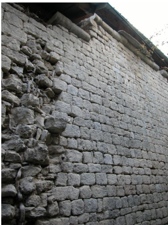
Fig. n° 113. A. Mur gouttereau nord de l'église Saint-Jean : continuité du parement et décroché dans la partie haute. B. Continuité des assises au-dessous d'une des trois zones d'arrachement du mur nord (cl. M. Varano).
