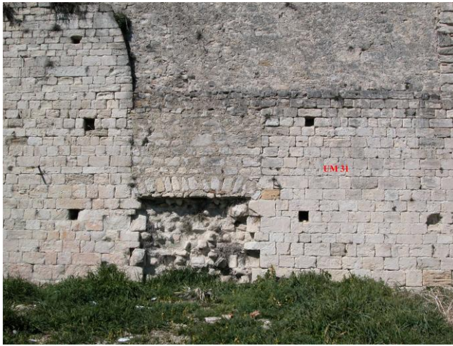
Fig. n° 10. Saint-Mary, mur 31 avec l'arrachement intermédiaire (cl. M. Varano).
