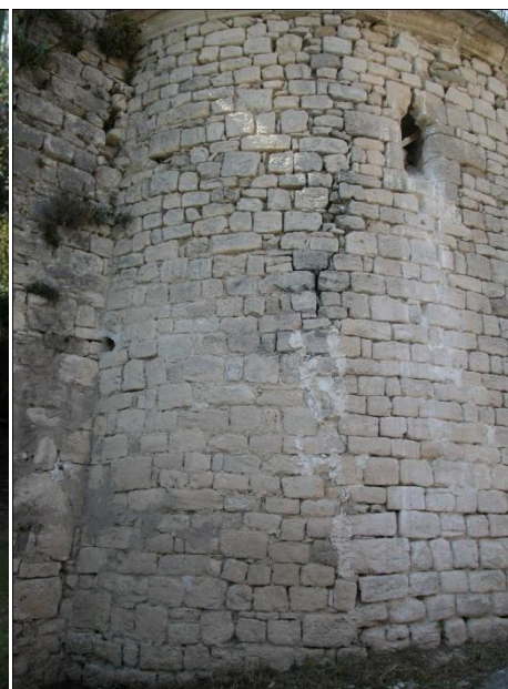
Fig. n° 107. Chevet de Saint-Jean avec le jour et l'interruption visible dans le parement (cl. M. Varano).
