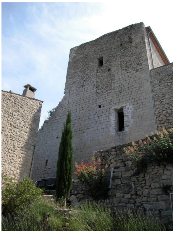
Fig. n° 177. Parement du mur ouest (UM 4) de la tour B (cl. M. Varano).
