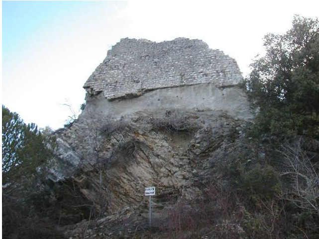
Fig. n° 149. Donjon vu du fond du fossé, au nord (cl. M. Varano).
