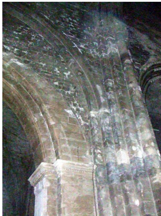
Fig. n° 93. Contact entre les maçonneries de l'arc aveugle médiéval et de l'ouverture moderne à la jonction de la deuxième travée nord avec le pilier donnant accès au transept (cl. M. Varano).
