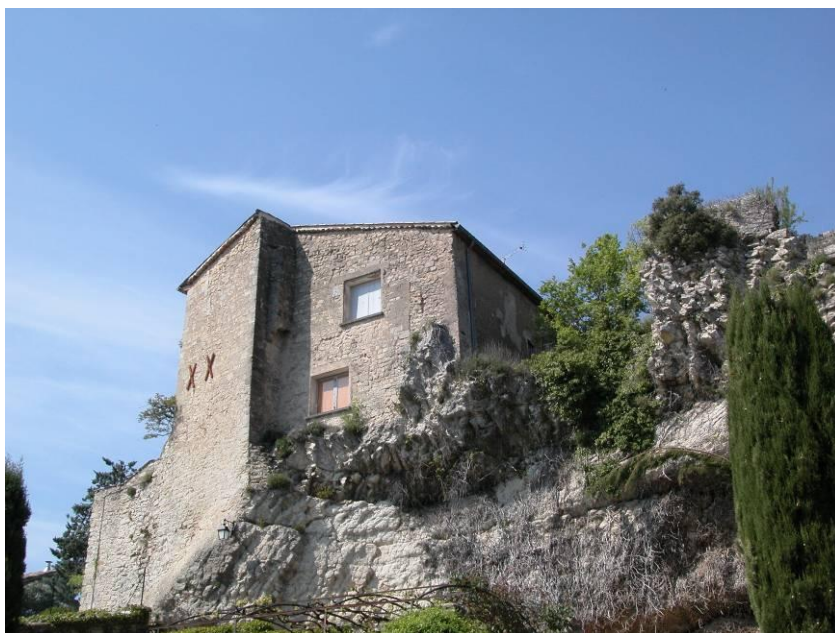
Fig. n° 156. Profil du fossé creusé dans le substrat de nos jours (cl. M. Varano).
