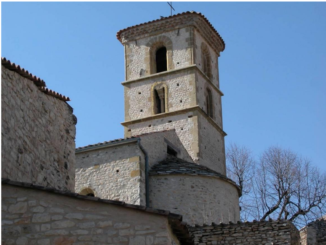
Fig. n° 46. Clocher de l'église Saint-Jean-Baptiste de Mallefougasse, vue du sud-est (cliché M. Varano).
