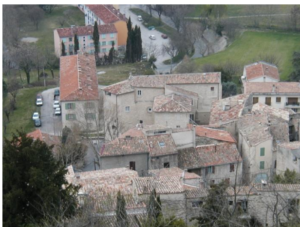
Fig. n° 120. Vue du mur percé d'un oculus correspondant à la façade de l'église détruite Saint-Pierre (cl. M. Varano).
