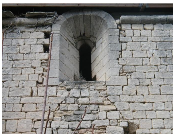
A. B. Fig. n° 110. Fenêtres à double ébrasement percant le mur sud de Saint-Jean : A. fenêtre de la deuxième travée orientale ; B. Fenêtre de la première travée ouest (cl. M. Varano).
