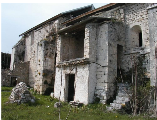
Fig. n° 109. Vue générale de la façade méridionale de Saint-Jean (cl. M. Varano).
