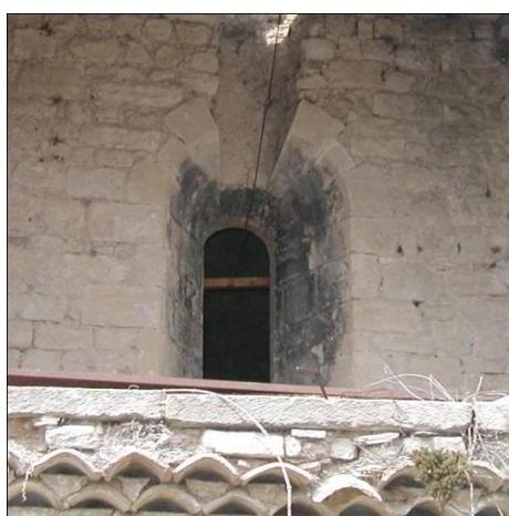
A. B. Fig. n° 110. Fenêtres à double ébrasement percant le mur sud de Saint-Jean : A. fenêtre de la deuxième travée orientale ; B. Fenêtre de la première travée ouest (cl. M. Varano).
