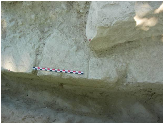
Fig. n° 22. Marque sur la face supérieure d'un bloc appartenant au mur de fondation. Elle devait indiquer l'emplacement de l'angle de l'abside en pans coupés, comme il le témoigne le moellon supérieur (cl. M. Varano).
