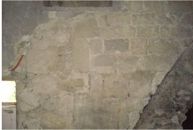
Fig. n° 161. Vestiges du jour méridional vus de l'intérieur du logis (cl. M. Varano).
