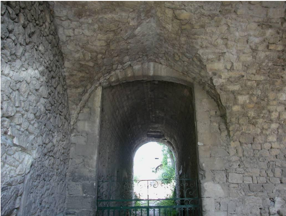
Fig. n° 151. Entrée voûtée donnant accès à la moitié occidentale du château (cl. M. Varano).
