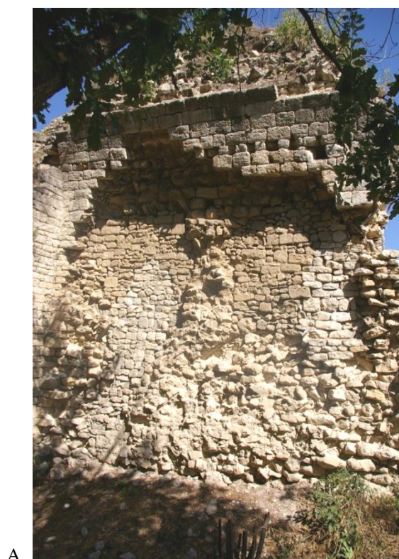
Fig. n° 70. A. Pièce A, départ de la voûte sur le mur oriental. B et C. Détails du départ de la voûte dans la Pièce A (cl. M. Varano).
