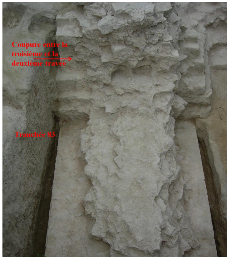
Fig. n° 32. Tranchée 83 et début de la fondation de la deuxième travée
