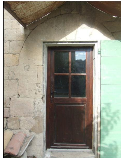
Fig. n° 127. Traces de la porte ouverte sur la façade occidentale du bâtiment annexe à l'église Saint-Promasse (cl. M. Varano).
