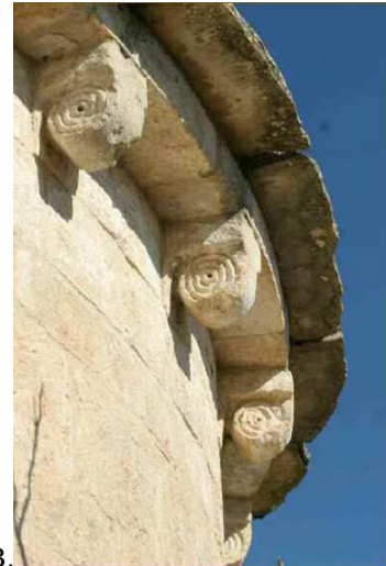
Fig. n° 56. A. Chevet de Saint-Jean-de-Fuzils (Patrimoine Architectural de Haute Provence). B. Détail des corbeaux décorés soutenant la toiture de l'abside (Autour de l'An Mil en pays de Forcalquier).
