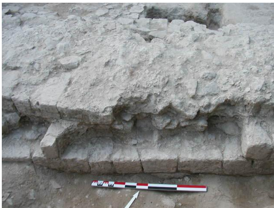
Fig. n° 48. Parement externe du mur du chœur, aménagé afin de délimiter une sépulture. En arrière plan, la fosse-reliquaire du côté intérieur du chœur (cl. M. Varano).
