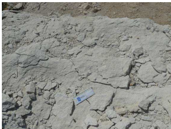
Figure 2-9 La Roche Béron – calcaire altéré
