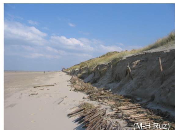
fin mars 2007 : falaise sableuse d'érosion, mise à nu des anciennes ganivelles
