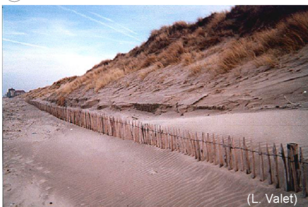
fin janvier 2002 : mise en place de rangées de ganivelles et accumulations sableuses en pied de dune
