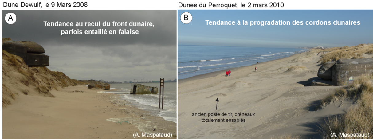
Figure V-4 Localisation de marqueurs militaires, témoins de l'évolution du trait de côte, sur le littoral à l'Est de Dunkerque.
