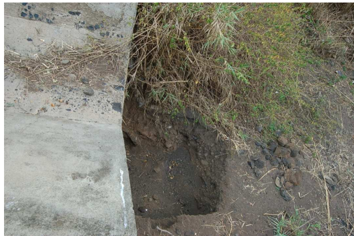
Figure 36 : Fossé de piège à sédiment
