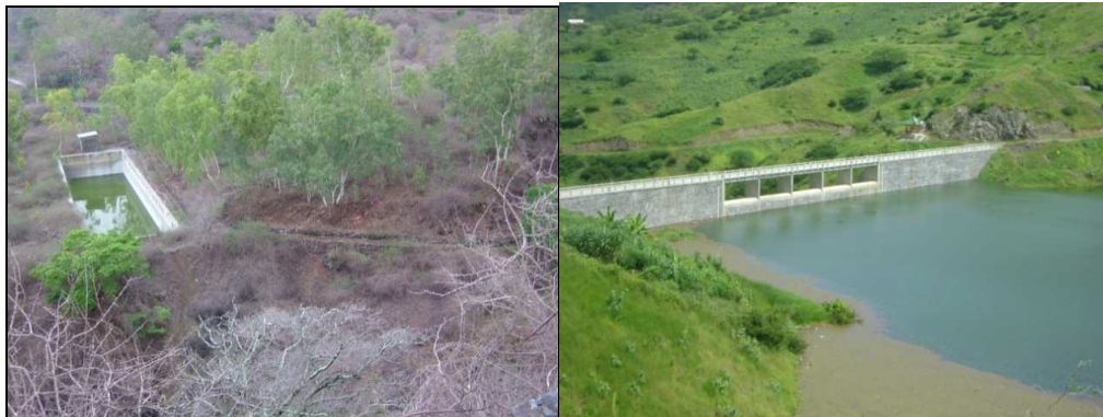
Réservoirs d'eau (Storage reservoirs) à gauche et le barrage (Dam) hydro agricole de Poilão. Ces ouvrages jouent un rôle notoire pour l'irrigation des cultures en période sèche.
