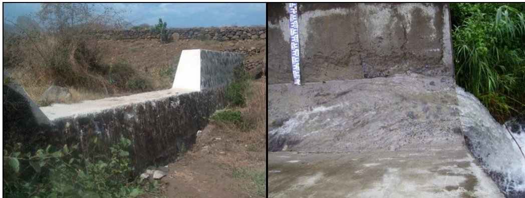
Digues (check dams) à l'embouchure de Ribeira Grande (à gauche) et Ribeira de Longueira (à droite). Ces ouvrages réduisent la cinétique des eaux d'écoulement, obligent les crues à déposer leur charge sédimentaire et permettent aussi à l'eau de s'infiltrer.
