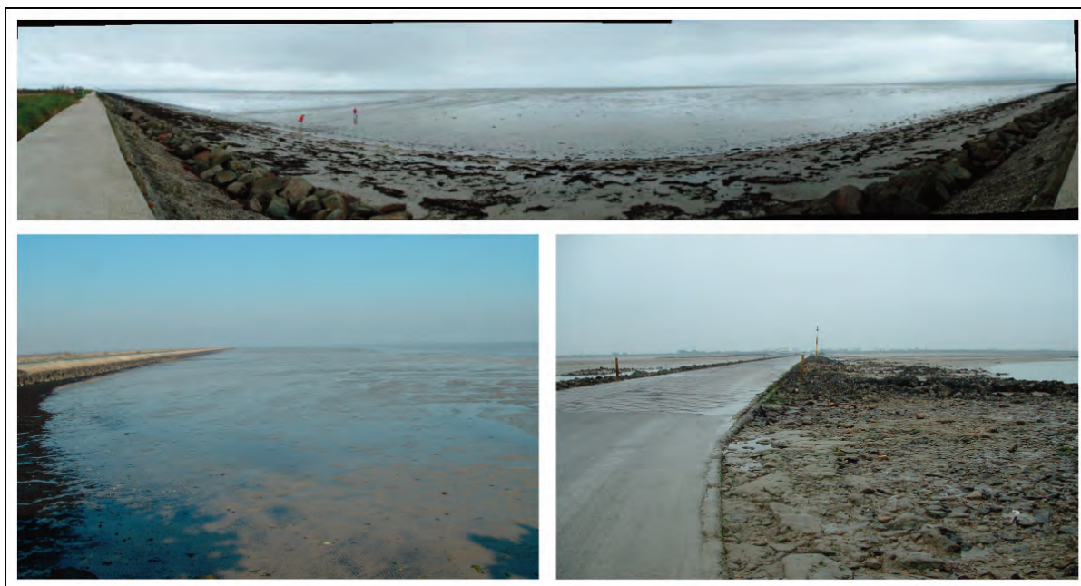
Figure II : Vue panoramique de la zone d'étude depuis Cailla (Nord de la zone) en haut, vue de l'estran et de la digue du polder de Sébastopol, en bas à gauche, et vue du passage du Gois, en bas à droite.
