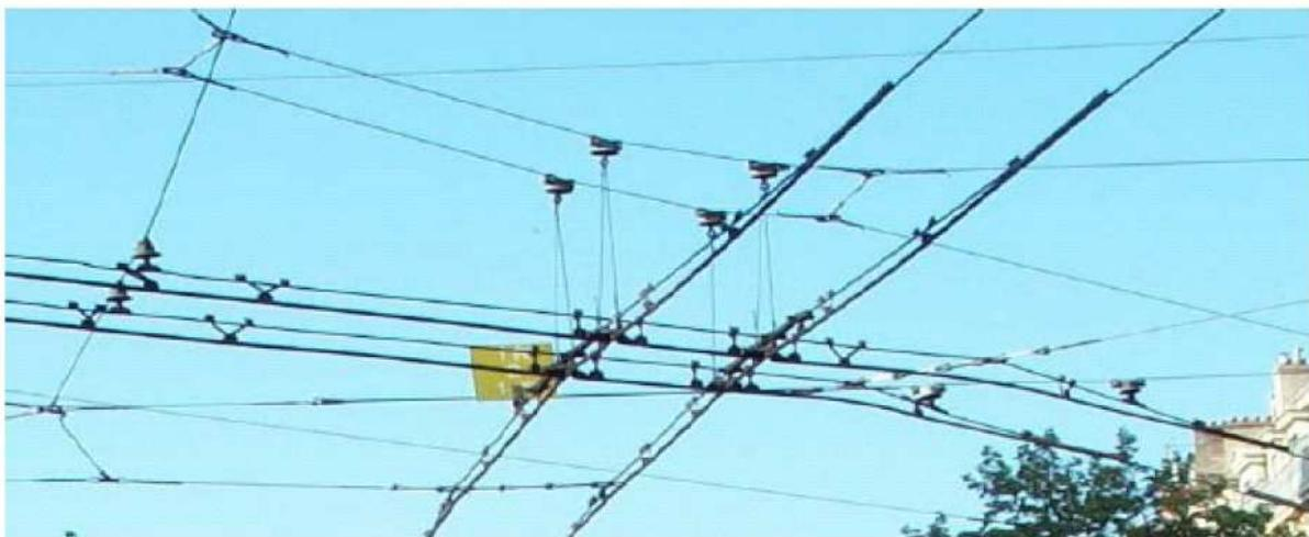
**Figure 1.16 : Exemple de traversée sur la ligne d'alimentation du trolley.**
