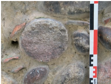
Tronçon de colonne employé dans le mur occidental de la sacristie de l'église Saint Michel
