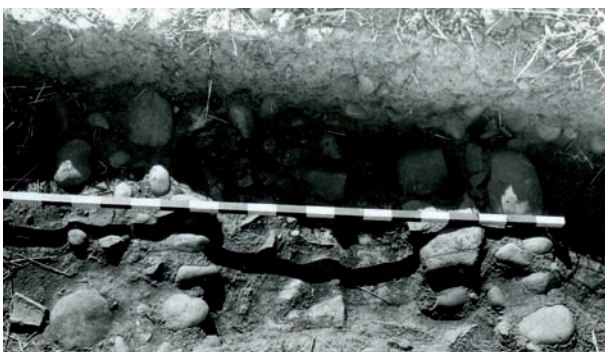
Détail des fondations vues de l'est, carré C-IV
