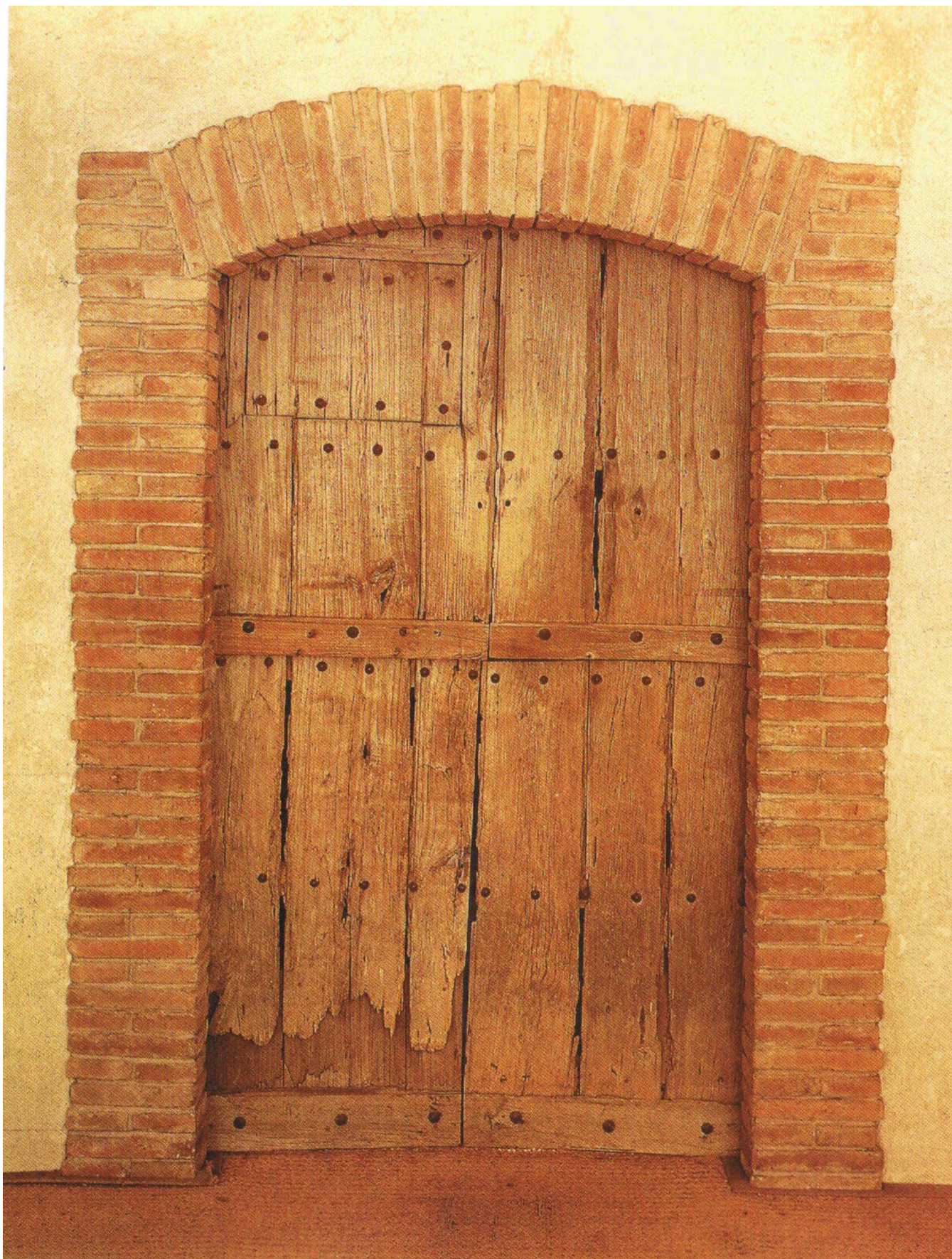
141. Etant donnés : 1° la chute d'eau, 2° le gaz d'éclairage, 1946-1966, vue frontale de l'installation
