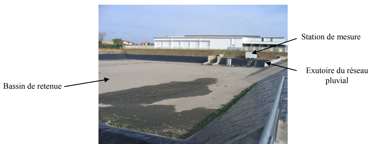
Figure 7.6. Photographie de la station de mesure installée en entrée du bassin de retenue décaantation à Chassieu
