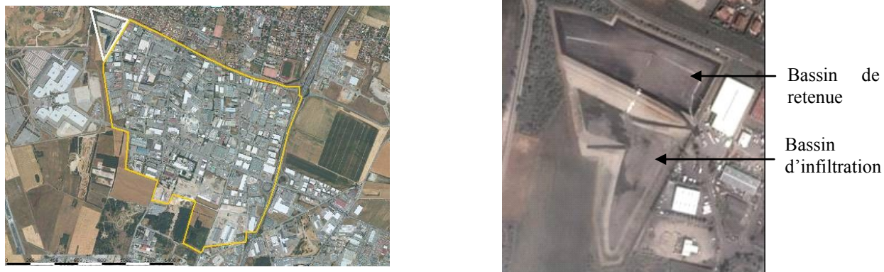
Figure 7.2. A gauche : Vue aérienne du bassin versant de Chassieu-Django-Reinhardt. A droite : Vue aérienne des bassins de retenue et d'infiltration (Google Earth)
