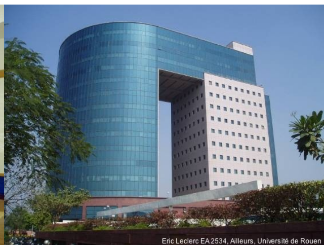
Signature Tower à Gurgaon
