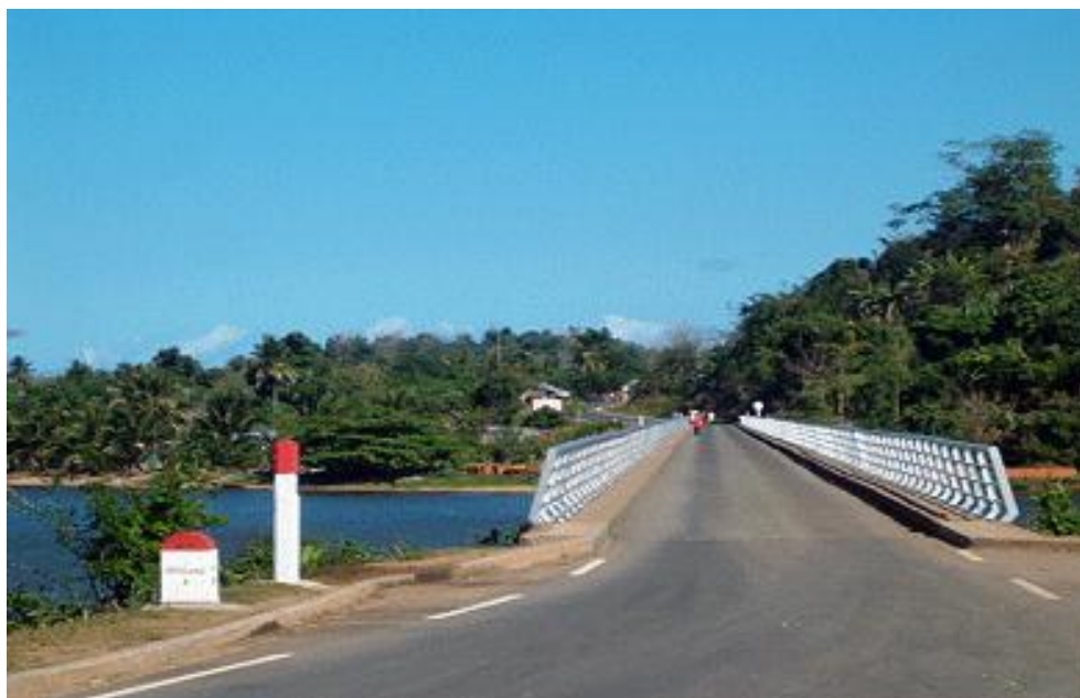
Photo 5 : Portion de la RN5 reliant Antalaha à Sambava
