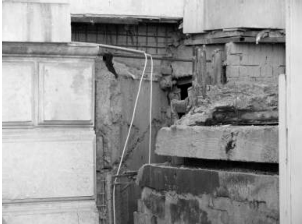
Figure 48 – Photographie avec un plan resserré de la façade Ouest appartenant à la Maison du Peuple. Derrière la pierre agrafée nous pouvons remarquer, malgré la mise en œuvre récente de ce bâtiment, sa structure en béton armé. (Crédit personnel)
