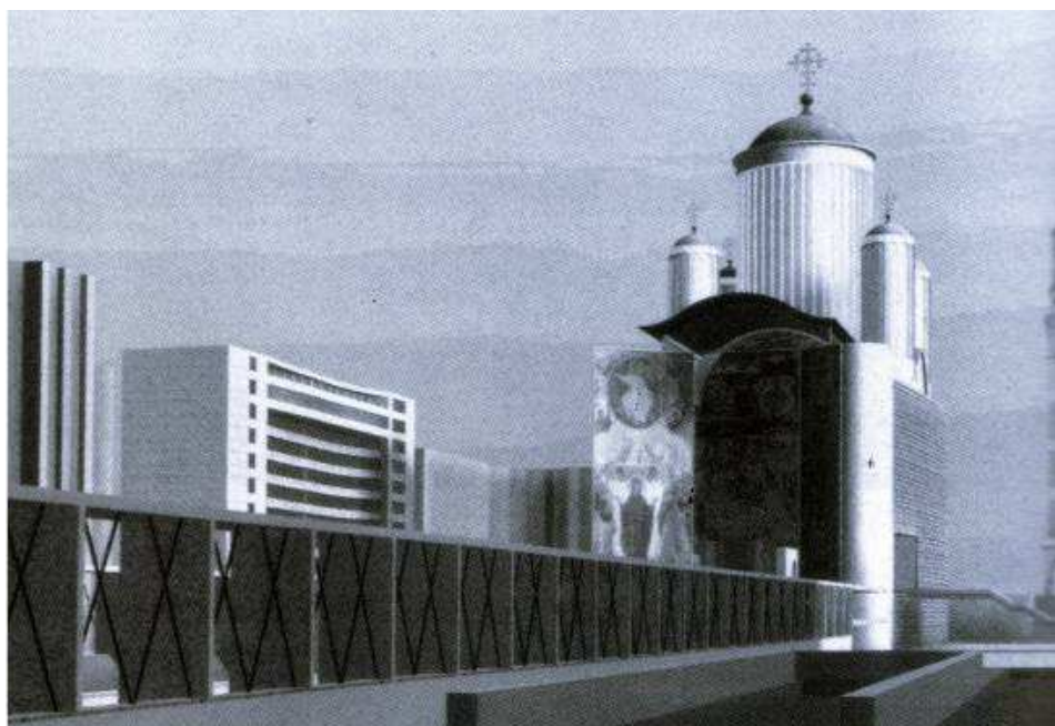
Figure 55 – Images de synthèse du projet lauréat pour la Cathédrale de la Rédemption Nationale. Sur la première image – le plan masse ; l'architecte Augustin Ioan avait proposé un édifice qui s'implanterait dans l'axe de l'avenue de Ceausescu. Source : Bucuresti, arhitectura si modernitate ; de Mariana Celac, Octavian Carabela, Marius Marcu Lapadat, éditions Arcub Simetria, Bucarest 2005.
