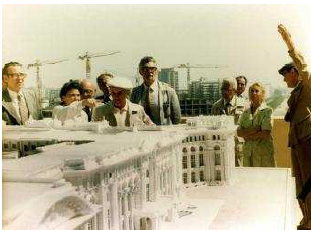
Figure 36 – Présentation aux dignitaires communistes d'une maquette à l'échelle 1/100 e de la Maison du Peuple sur le chantier même du projet. (Collection privée)
